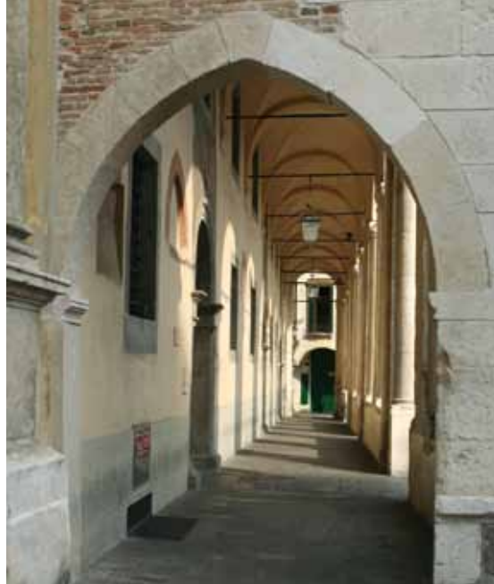
fig. 11. Monte di Pietà: l'arco di accesso al portico da ovest.
