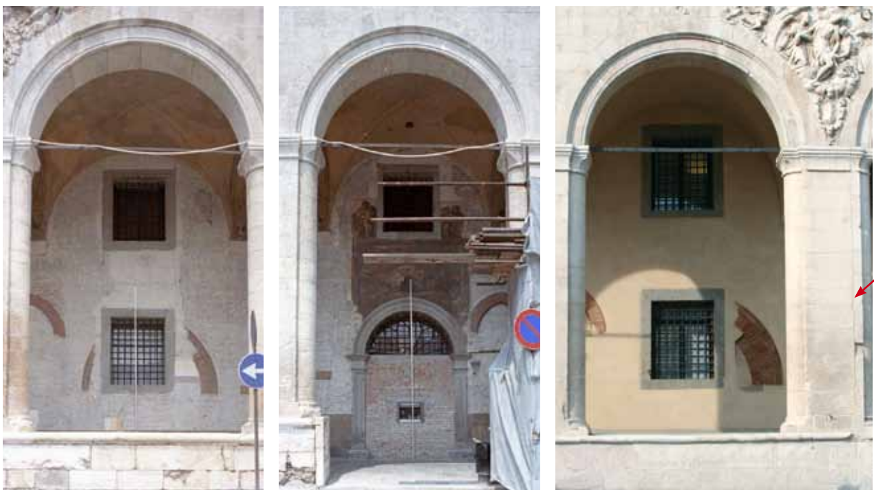
< fig. 9. immagini dei paramenti murari del portico delle sei arcate corrispondenti al palazzo a pianta trapezoidale (foto A. Maifreni del 1990; la foto della sesta arcata è di G. Candiani eseguita il 4.10.2012).
