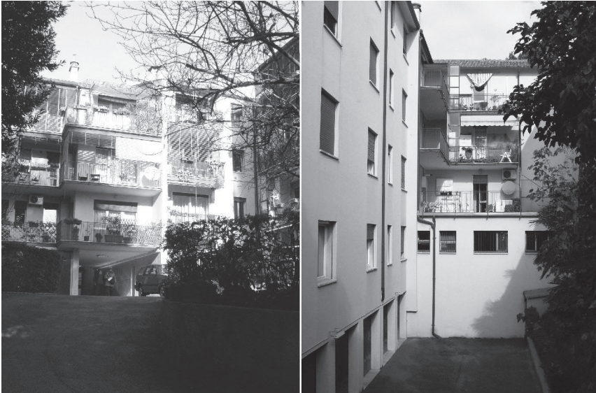
FIG. 60 - L'interno degli edifici condominiali sorti nei Vignali , sul sedime delle case Viali (a sinistra) e Cossavecchia (a destra): della scala scoperta e della loggetta secentesca non c'è più nessuna traccia.
