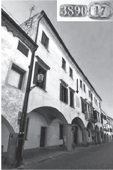
FIG. 39 - Padova, via Galileo Galilei 17, casa già Agugie, ora Bressanin. La freccia indica la lapide del 1959, nel riquadro il vecchio civico accanto all'attuale.
