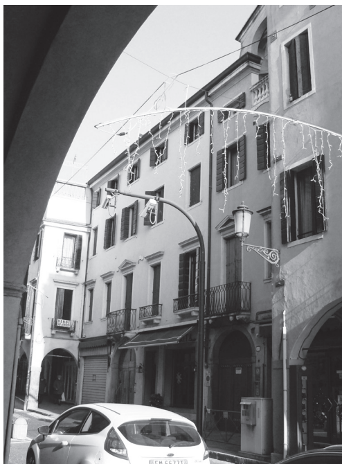
FIG. 35 - Padova, via del Santo 165-173, casa già Montagnana-Talamazzo, poi Ferri.
