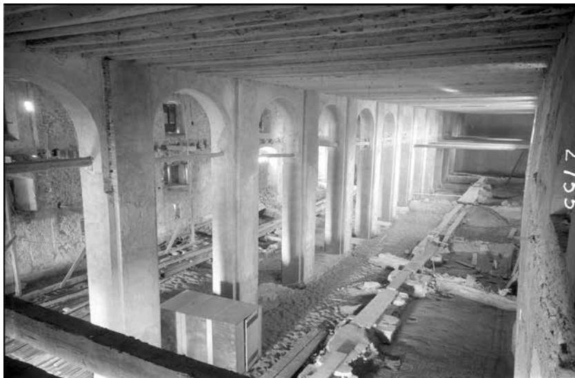
Fig. 4. Muro di spina nel folador di Monastero, Aquileia (Archivio Fotografico SABAP-FVG, neg. n. 2755).
