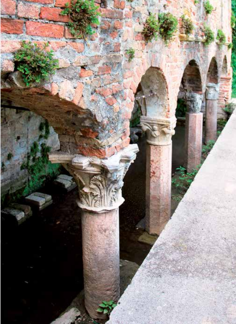
Tav. 31. Padova, convento di Sant'Antonio, "porto fluviale", particolare del portico al piano terra.
