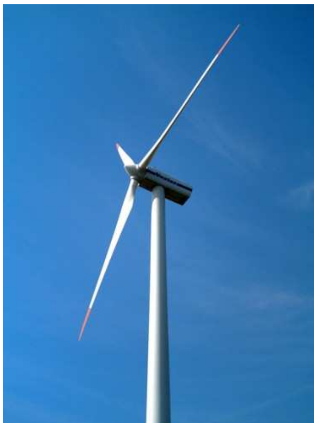
Figura 1.3: Esempio di aerogeneratore con rotore ad asse orizzontale
