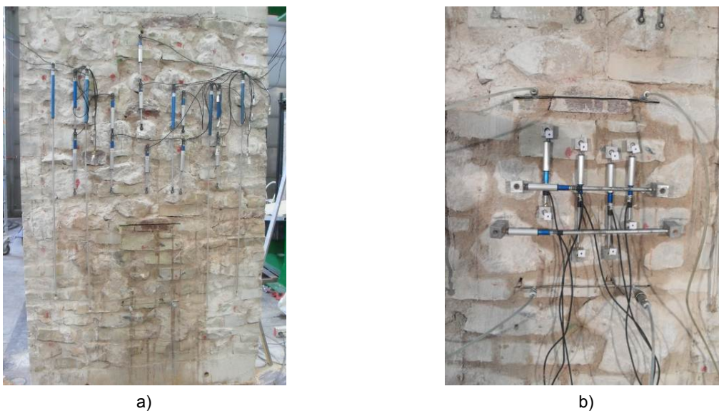
Figura 4.21 Realizzazione del secondo taglio per la prova di martinetto piatto doppio (a) e strumentazione installata (b).
