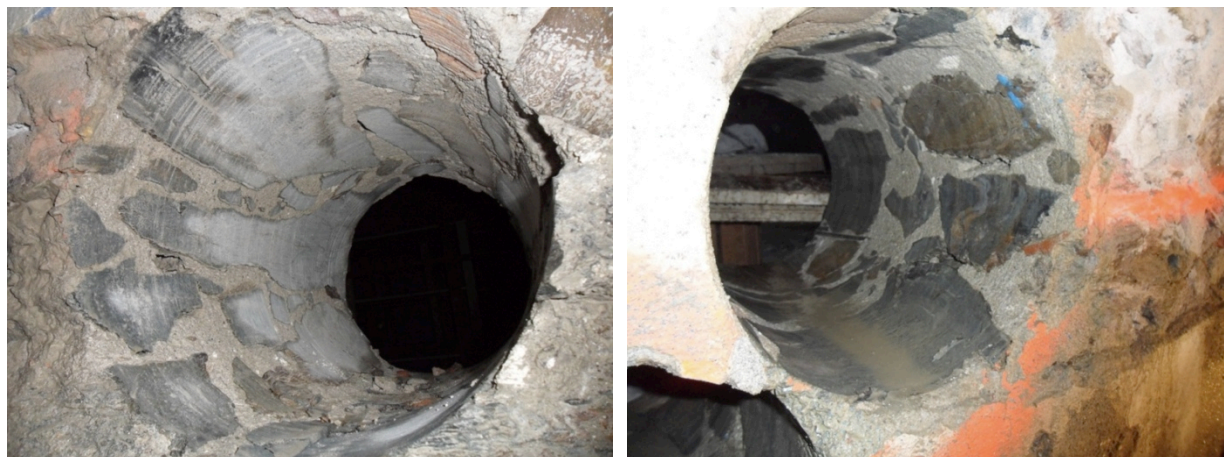
Figura 3.13 Carotaggi eseguiti sulle murature del piano terra.
