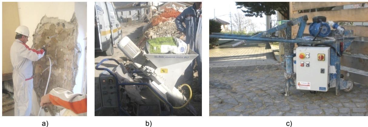
Figura 3.7 Lavaggio con latte di calce (a), pompa semiautomatica (b) e pompa manuale per iniezioni (c).
