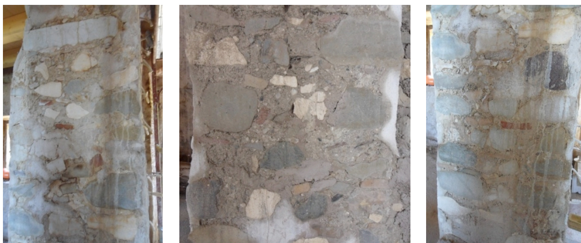
Figura 3.10 Sezioni murarie, pezzatura e ingranamento delle pietre.
