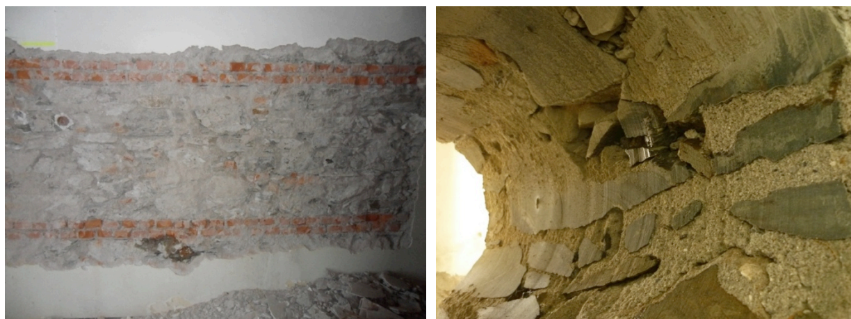
Figura 3.14 Muratura del primo piano con ricorsi in mattoni (a), Carotaggi eseguiti sulle murature del primo piano (b)
