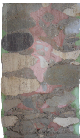
Figura 3.11 Sezione muraria, in rosso è evidenziato il materiale iniettato, in verde la ristilatura.
