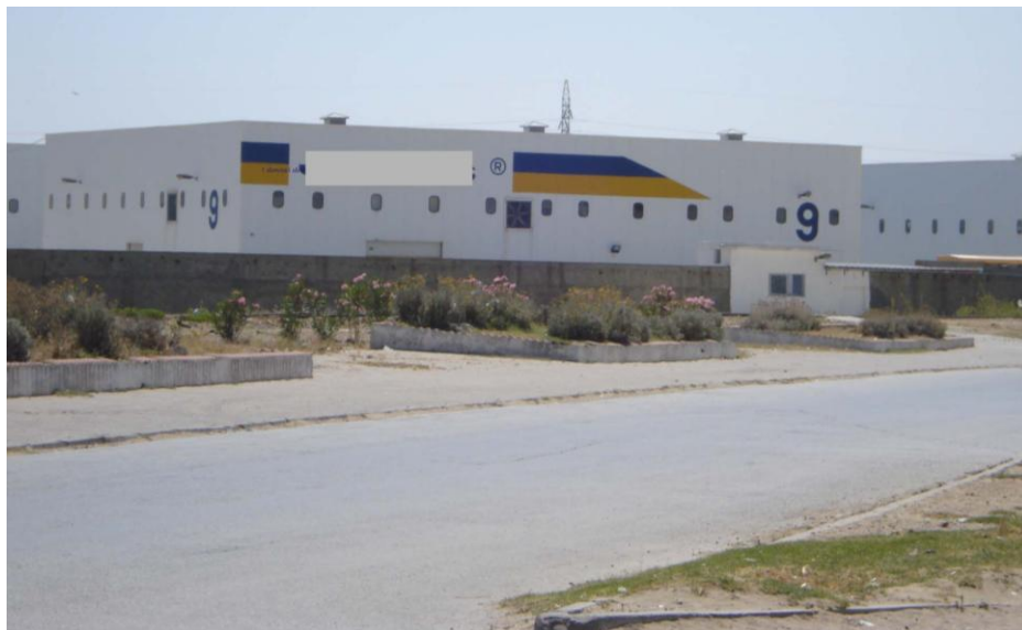
Fig. 30: uno dei capannoni dell'azienda 6 (Foto A. Alaimo).
