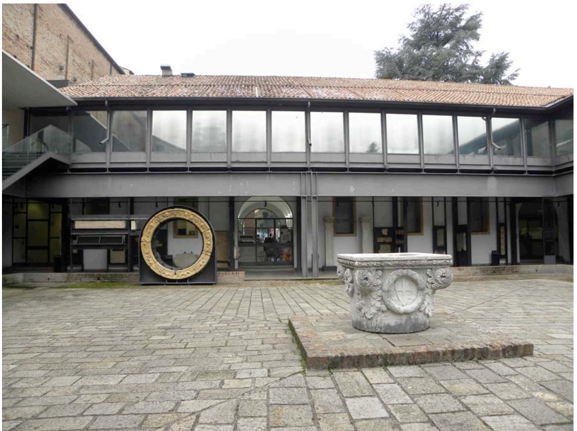
300. "Chiostro Albini", lato meridionale. 301. "Chiostro Albini", lato occidentale
