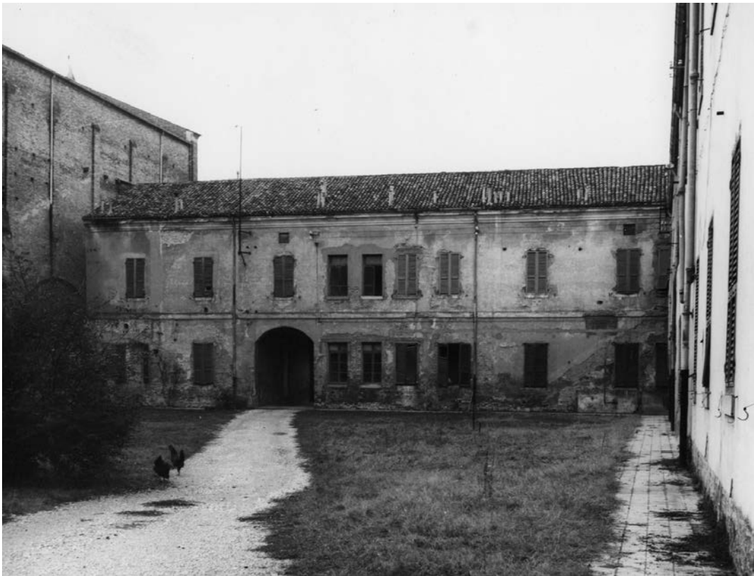
259. Lato meridionale del chiostro minore. 260. Lato occidentale del chiostro minore.
