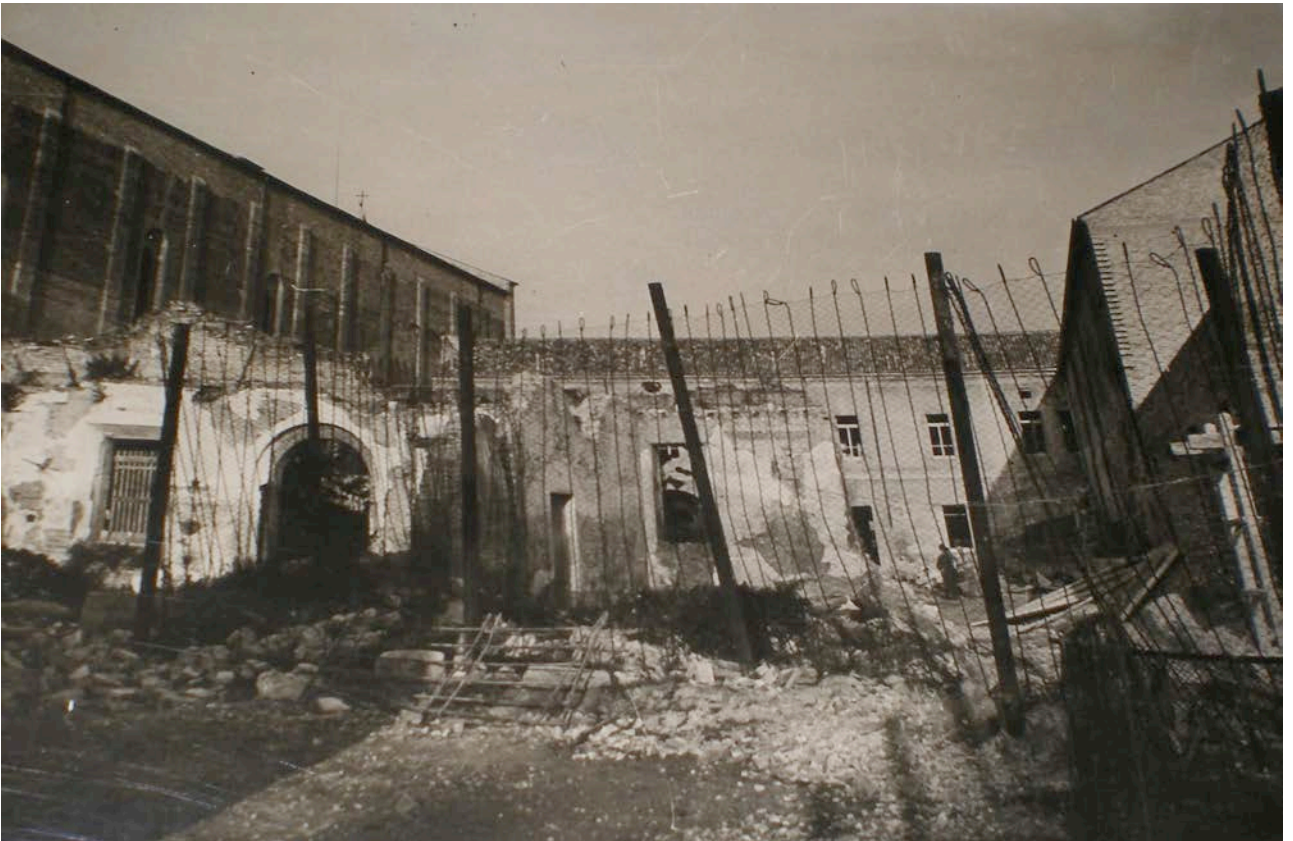
254. Muro settentrionale della chiesa dopo l'abbattimento dell'avancorpo.
