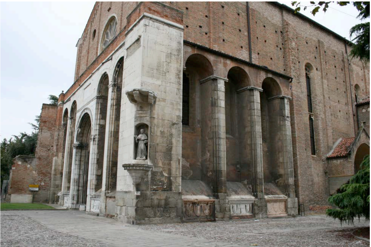
70. La facciata oggi.
