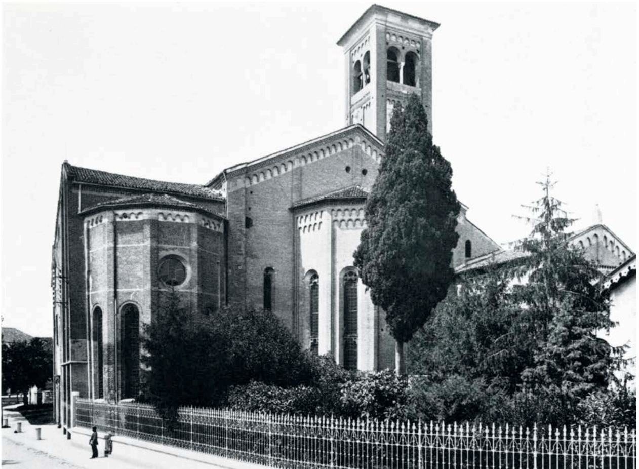
6, 7. Veduta absidale dopo la costruzione dell'inferriata
