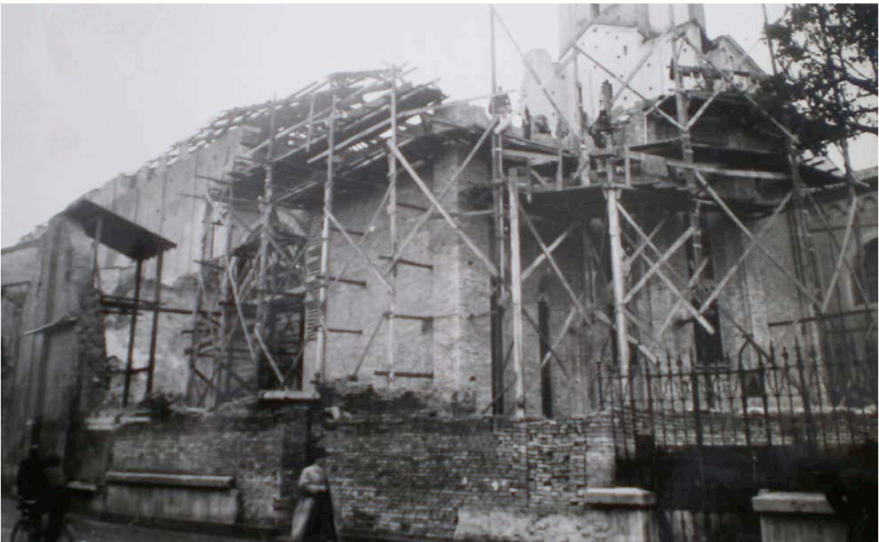
41, 42. La ricostruzione della chiesa.
