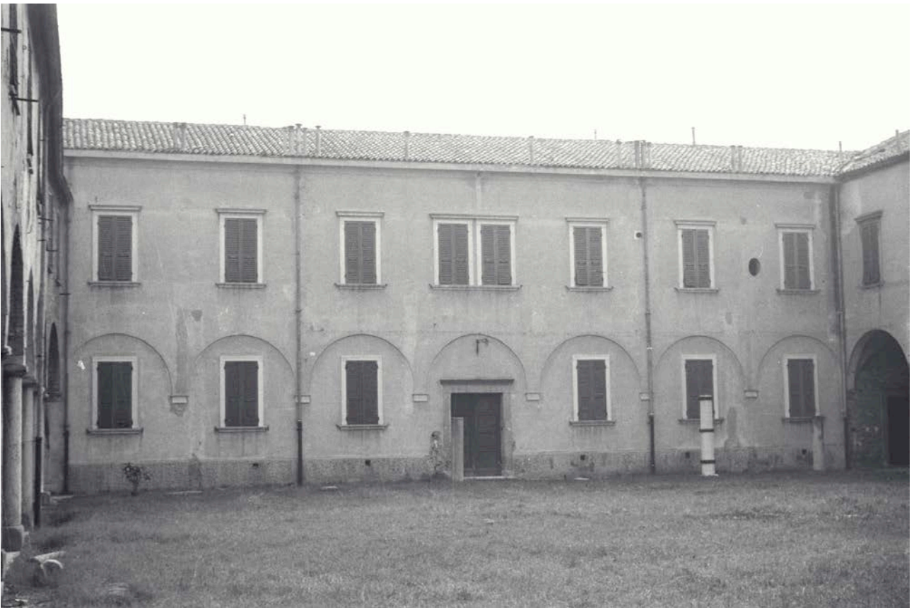
265. Chiostro maggiore, lato nord, ottobre 1966. 266. Chiostro maggiore, lato est, ottobre 1966.
