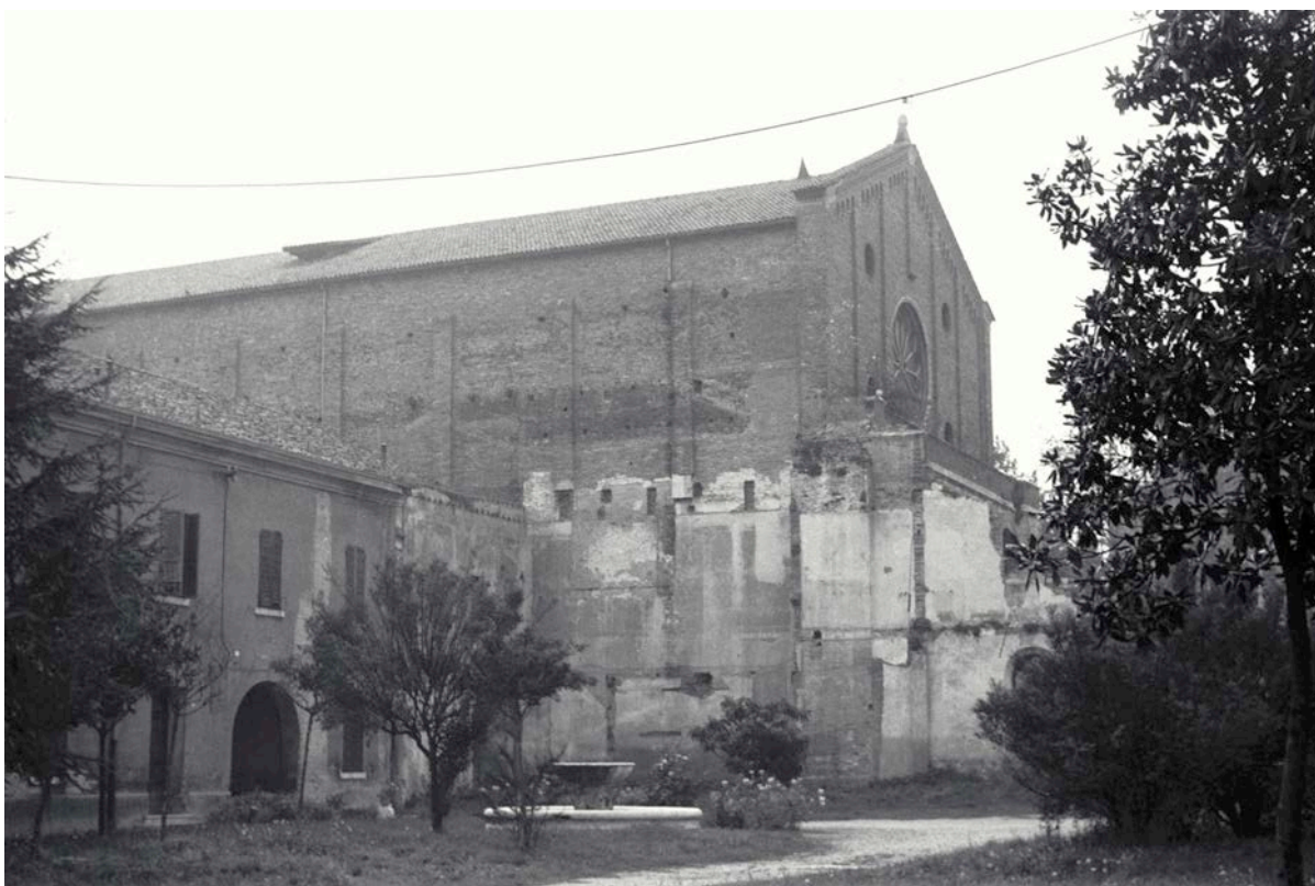
252. Corte d'ingresso prima della demolizione dell'avancorpo.
