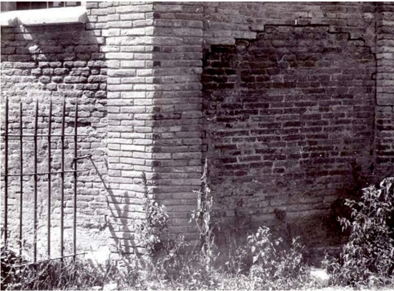
56, 57. Linea nera che segna il limite tra la muratura originale e quella risarcita.
