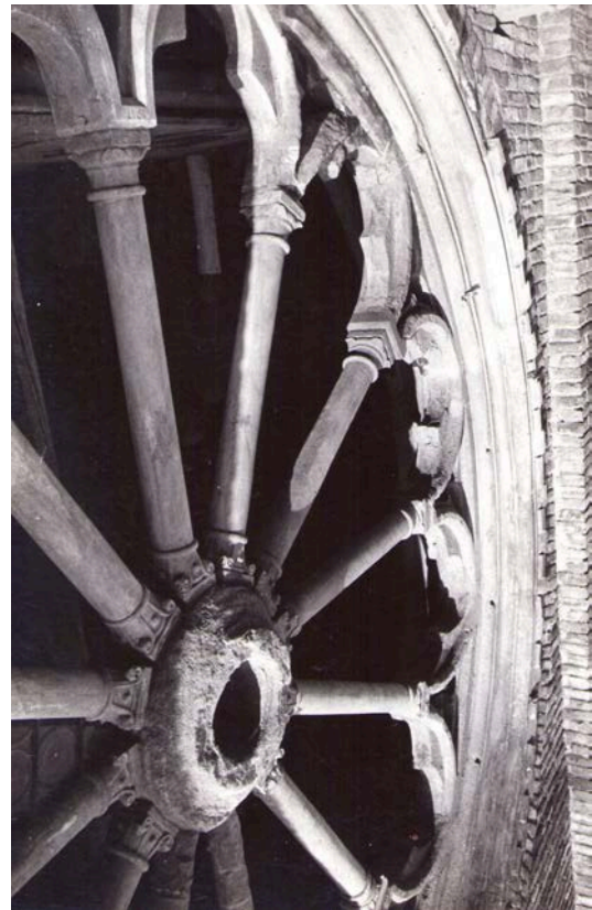
56, 57. Linea nera che segna il limite tra la muratura originale e quella risarcita.
