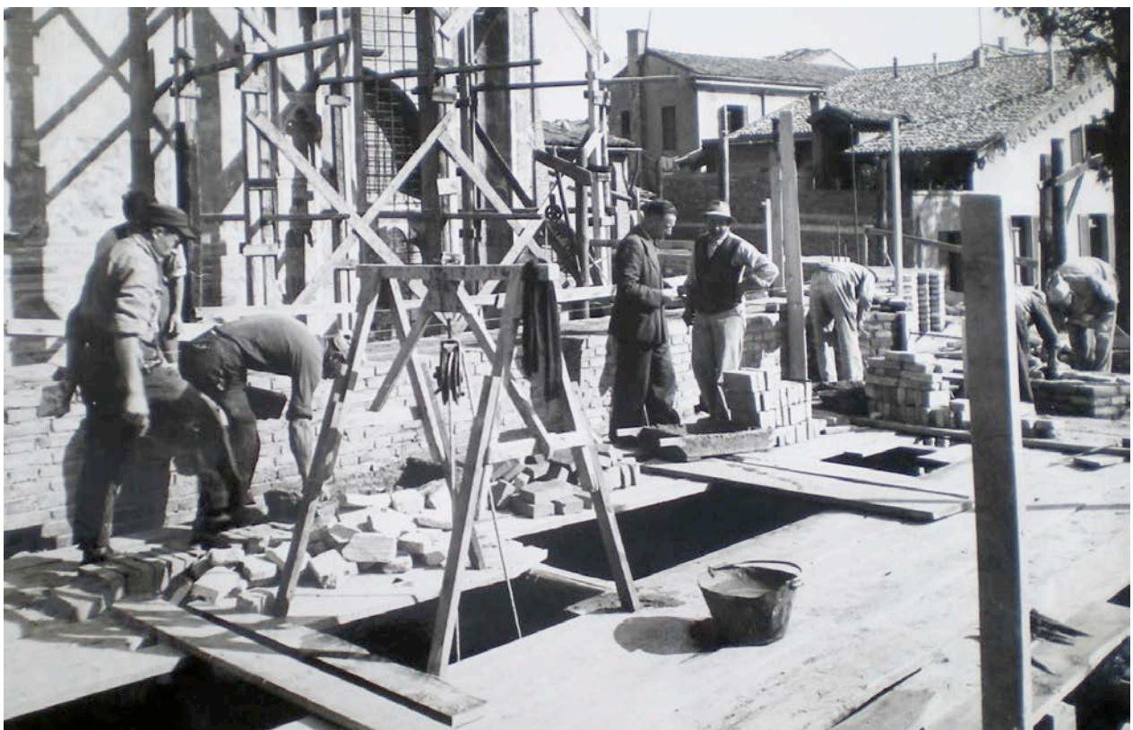
55. Un'altra immagine degli operai al lavoro nella ricostruzione della chiesa.
