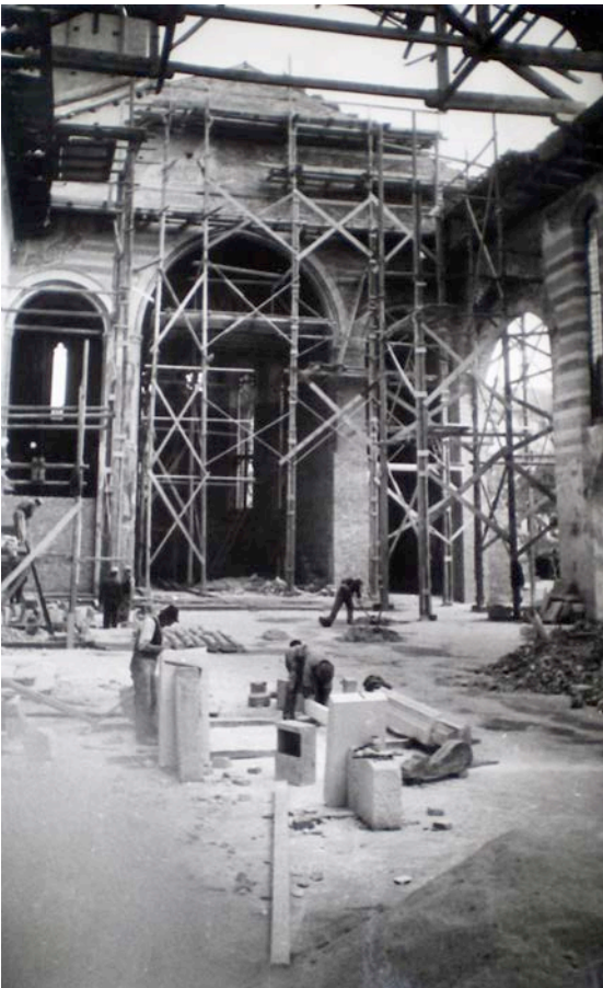
47, 48, 49, 50. Varie fasi nella ricostruzione della zona absidale.
