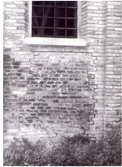
56, 57. Linea nera che segna il limite tra la muratura originale e quella risarcita.
