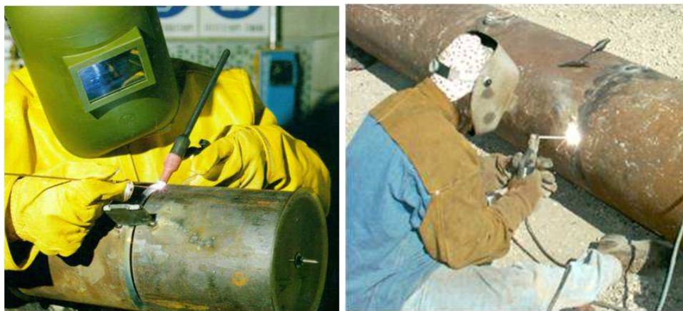
Fig.0.7 - Immagini di saldature in TIG (GTAW) e a Elettrodo rivestito (SMAW)
