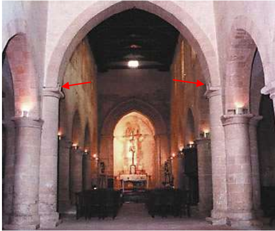
Fig. 310: Fori per l'alloggiamento della trave della croce, Naro, Santa Caterina.
