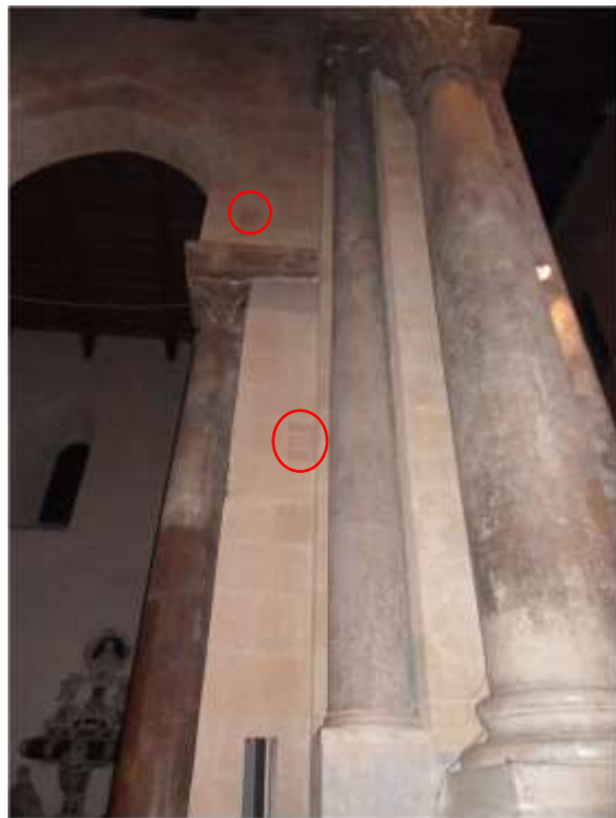
Fig. 307: Interno della cattedrale di Cefalù, fori tampognati che potevano essere l'alloggio per la trave della croce.
