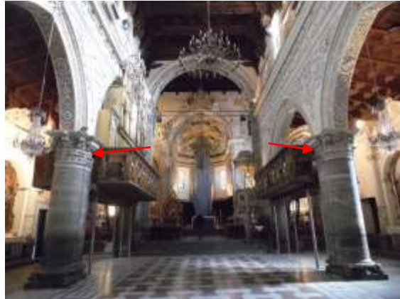
Fig. 311: Fori tampognati per l'alloggiamento della trave della croce, Enna, chiesa Madre.
