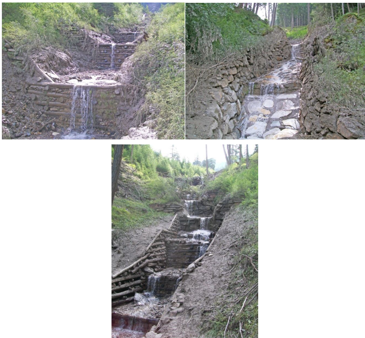
Fig. 4.12-4.14: Opere di SIF coinvolte dell'evento di colata detritica nel Luglio 2010 sul Rio Gadria (Foto Eventi ED30, Provincia Autonoma di Bolzano - Ripartizione Opere Idrauliche).
