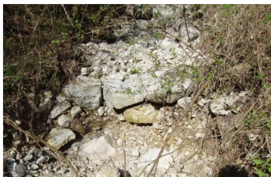
Fig. 3.23: Esempio di una delle circa venti soglie in massi realizzate dal Servizio Forestale Regionale
