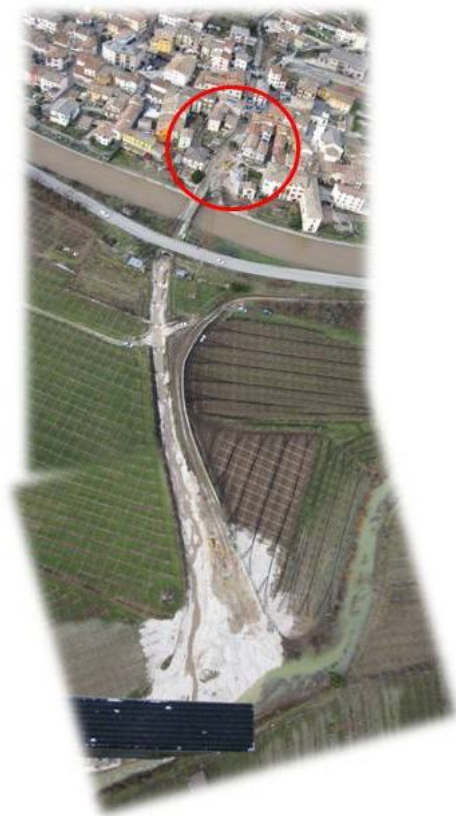
Fig. 3.53: Ripresa da elicottero dell'evento del 2009, si possono osservare le due principali zone di deposito, lateralmente al canale nella zona a pendenza negativa (area cerchiata) e ovviamente in confluenza con il Rio Molini a valle del canale artificiale
