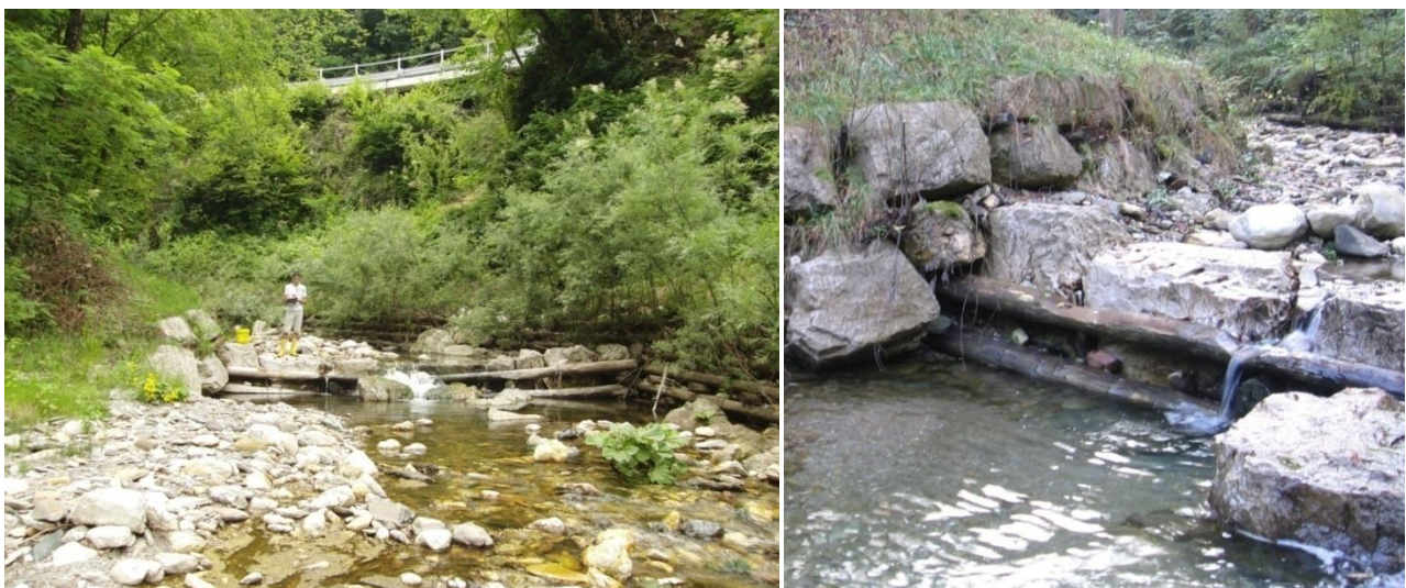
Fig.4.2: Log step e palificata spondale lungo il torrente Sterbise, particolare scogliera in massi rinverdita ed erosione sugli elementi longitudinali del log step sullo Sterbise
