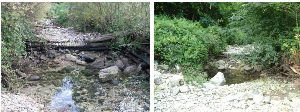
Fig. 4.3: Buche a valle delle briglie lungo il torrente Livergon
