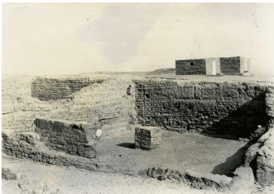
Fig. 242 – Il vano 11A (E nei diari). La mangiatoia era probabilmente inserita nel muro a sinistra dell'immagine dove si nota una fessura nella struttura muraria (MSA, fondo Anti, n. inv. 273, foto 002).
