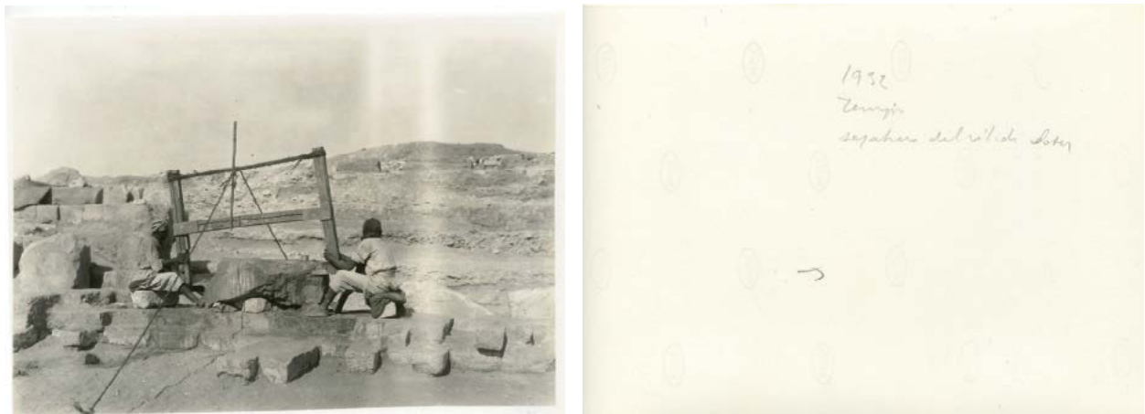
Fig. 41 – Operazioni di rimozione di un rilievo – una fotografia di prova. Il retro è manoscritto (MSA, fondo Anti, n. inv. 256, foto 081).
