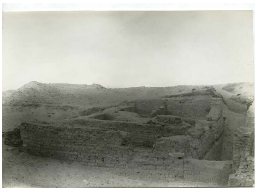
Fig. 94 – La casa 3 vista da oriente. Si identifica la struttura muraria, con mattoni crudi di grandi dimensioni e il muretto tardo, lo “sbatacchio”, che vi si appoggia sul lato nord e che connette gli edifici 3 e 5 (MSA, fondo Anti, n. inv. 257, foto 006).
