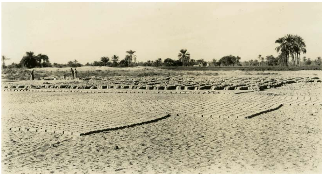
Fig. 275 - Preparazione dei mattoni crudi per la casa: fase dell'essiccazione (MSA, fondo Anti, n. inv. 269 foto 005).
