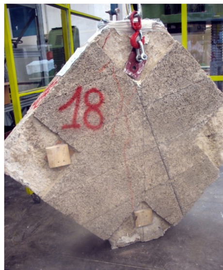
Figure 9-18. failure of panel n.18
