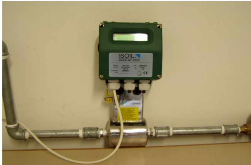
Fig. 4.7: il misuratore di portata elettromagnetico.
