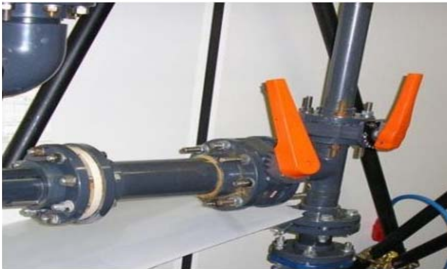
Fig. 4.12: valvola di regolazione entrata (destra) e valvola by-pass (sinistra).
