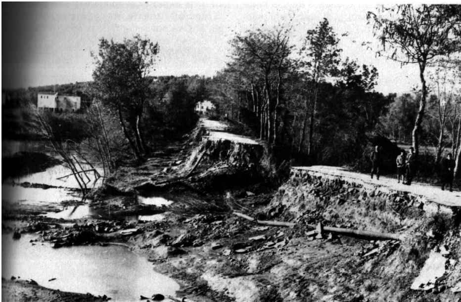
Figura 1.3 Rottura di argine causata dal trasporto di materiale legnoso nel Fiume Ombrone (Toscana, 1966), (Lezione_Rinaldi, 2006).
