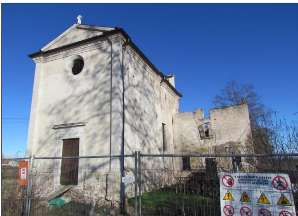
Fig. 2.1 – La chiesa di San Pancrazio, a Mezzane di Calvisano (BS).
