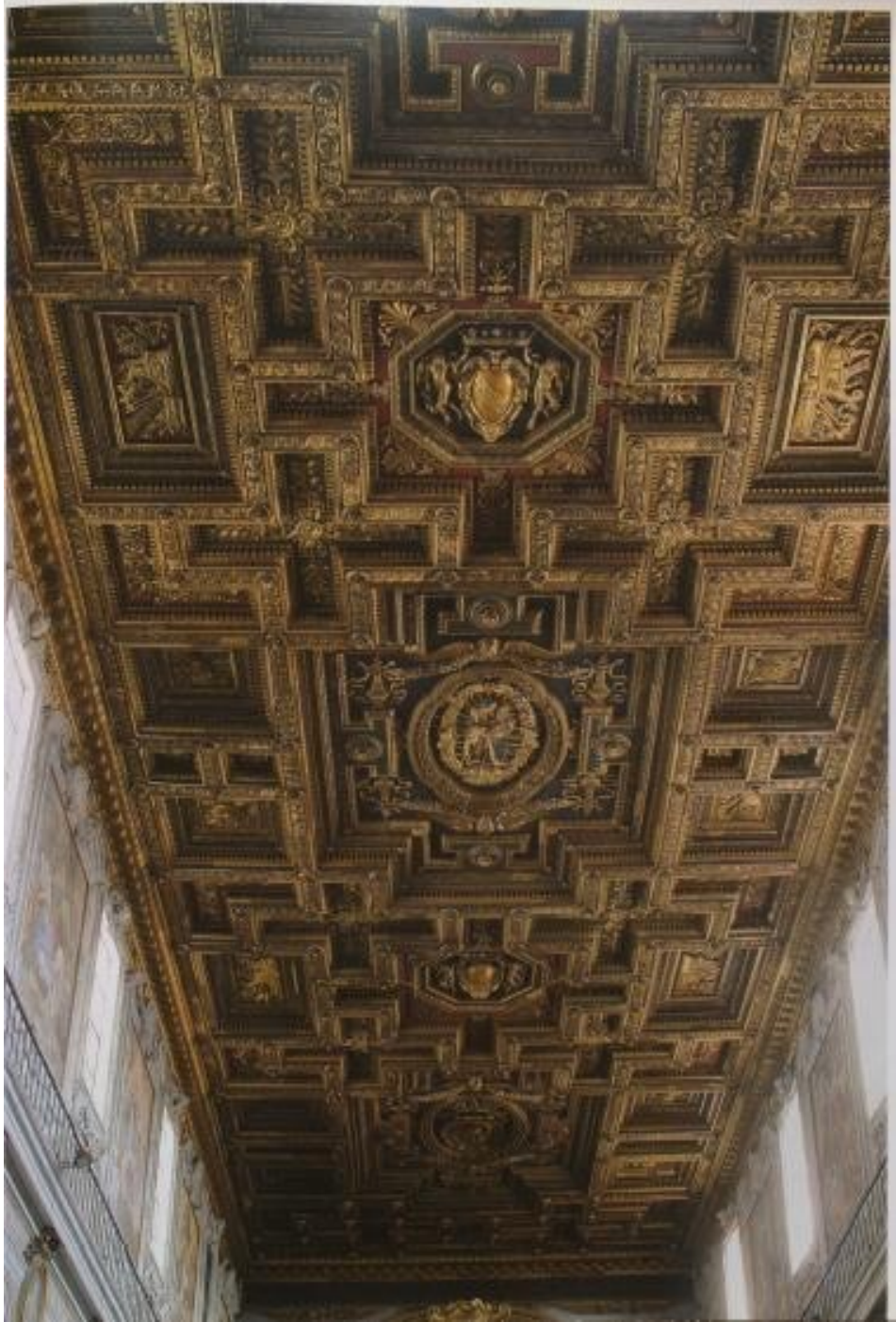
Figura 168: Soffitto Ligneo. Roma, Santa Maria in Aracoeli
