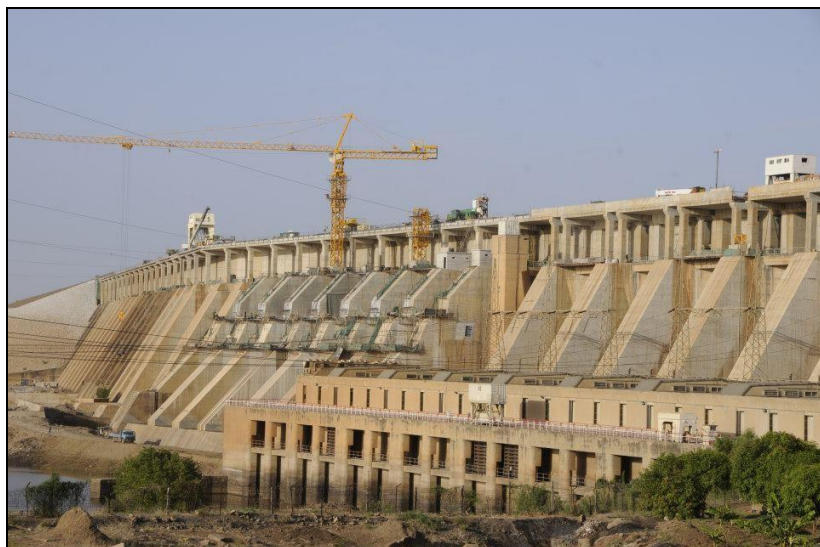
Figura 22 La diga di Roseires durante i lavori di innalzamento. (Dams Implementation Unit).
