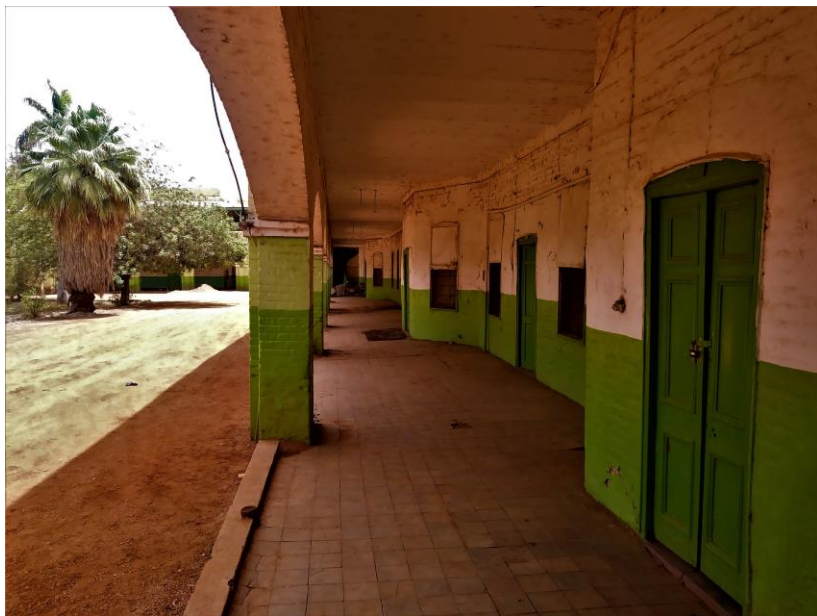
Figura 32 Sede SGB ( uffici ). Gli uffici a piano terra nella sede del Sudan Gezira Board (S. Turrini, 2018).
