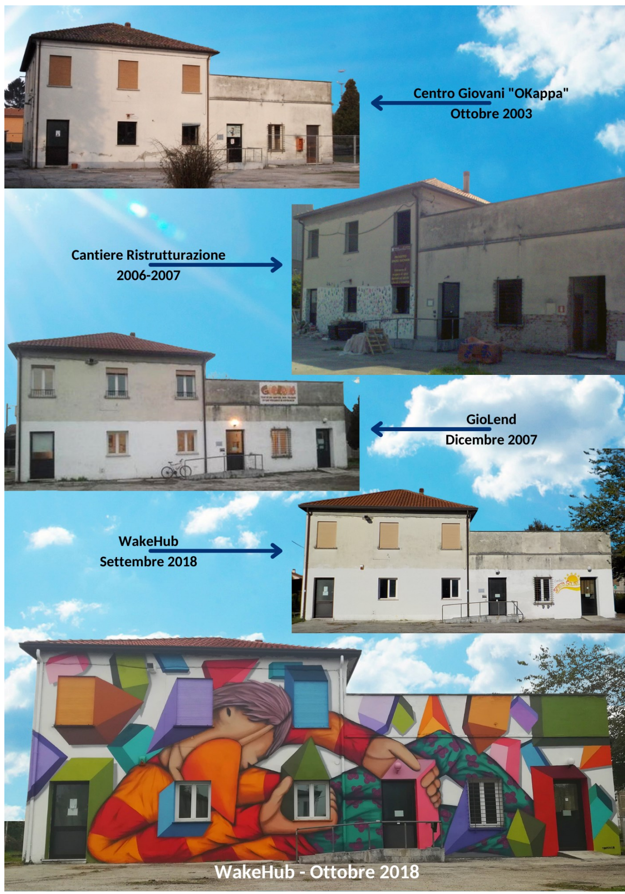
Figura 10 - nell'immagine l'evoluzione dell'aspetto dell'immobile di via Caduti del Lavoro 33
