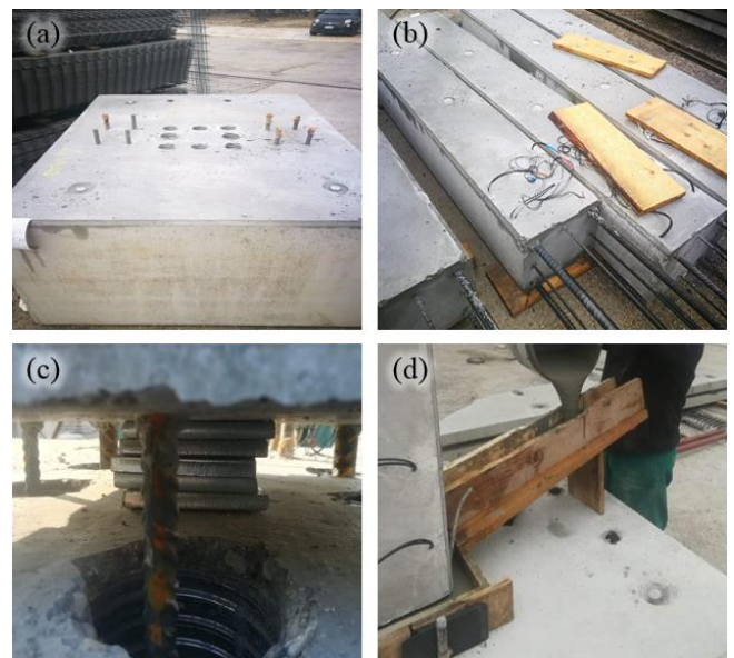
Figure 4. Realization of the grouted connections / Realizzazione delle connessioni iniettate.
