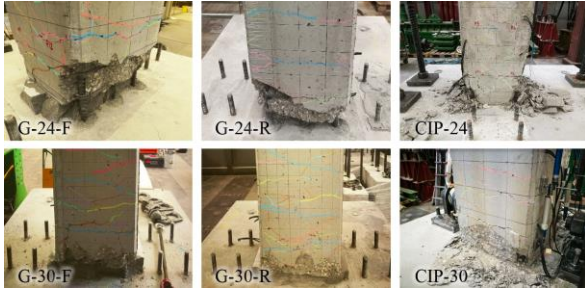
Figure 8. Damage extension / Estensione del danneggiamento.
