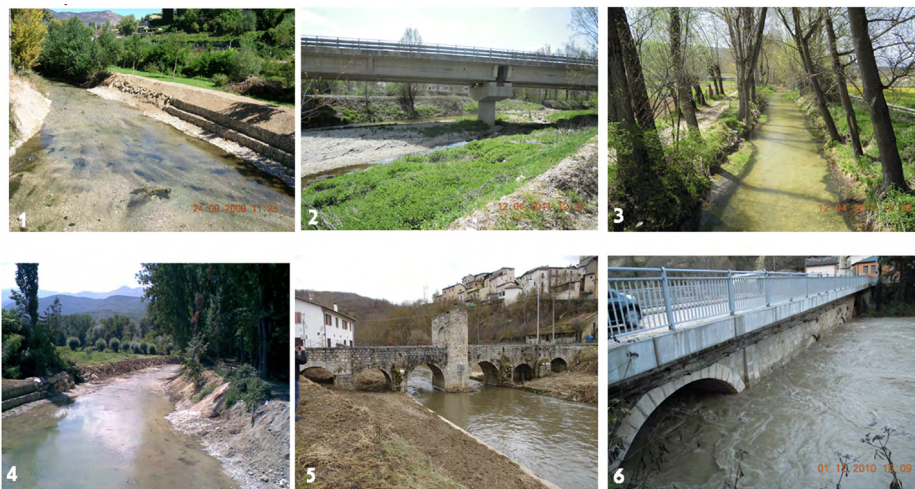
Fig. 2 - Alcuni settori del corso fluviale dell’Aterno: Foto n. 1 e 4 scavi, difese spondali e arginature, n. 2 passante stradale della variante Sud, n. 3 sezione ristretta in area agricola in condizioni di media qualità ambientale, n. 5 la sezione ridotta al ponte storico di Campana, n. 6 un evento di piena del 2010 in corrispondenza del Ponte della Rivera
