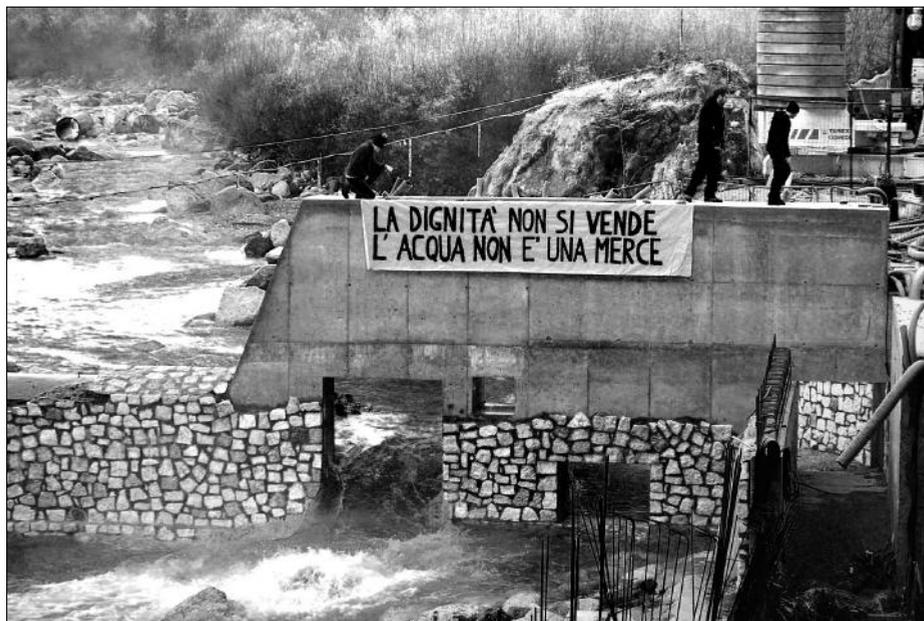
Fig. 5 – *Il cantiere dell'impianto micro-idroelettrico del Mis con l'opera di presa, parzialmente rivestita di «pietrame locale», usata come palcoscenico per la protesta*
