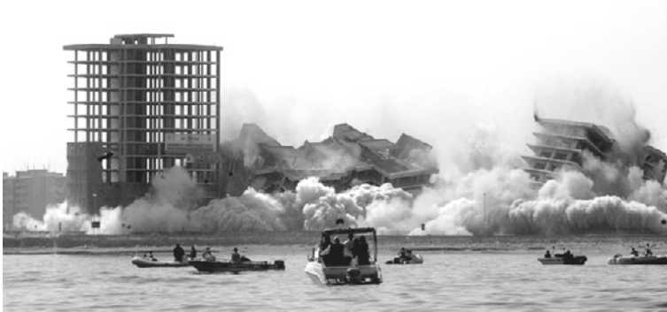
2.2 Demolizione dell'ecomostro di Punta Perotti, Bari, 2006
