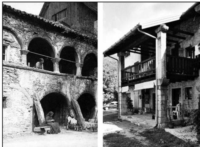
**Figure 1-2** - Esempio di edilizia tipica ad Ovaro in una fotografia d'epoca, dove si notano rilevanti modifiche ai prospetti quali la tamponatura degli archi esistenti per esigenze funzionali (a sinistra). I materiali vengono sapientemente utilizzati per tessere elaborate membrature murarie nelle architetture locali, come a Tarpana, Platischis (a destra) (da Croatto G., Gentilli R.)
