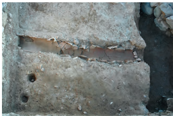
Fig. 6. Nora, Tempio romano. Canalizzazione in anfore pertinente a sistema di drenaggio stradale di età tardorepubblicana (BERTO et alii 2012, fig. 3, p. 2917).
