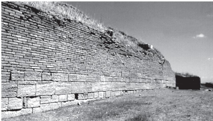
Fig. 3. Le mura di Apollonia di Illiria realizzate con basamento in pietra calcarea e parte superiore in laterizio cotto (*pentadora*).
