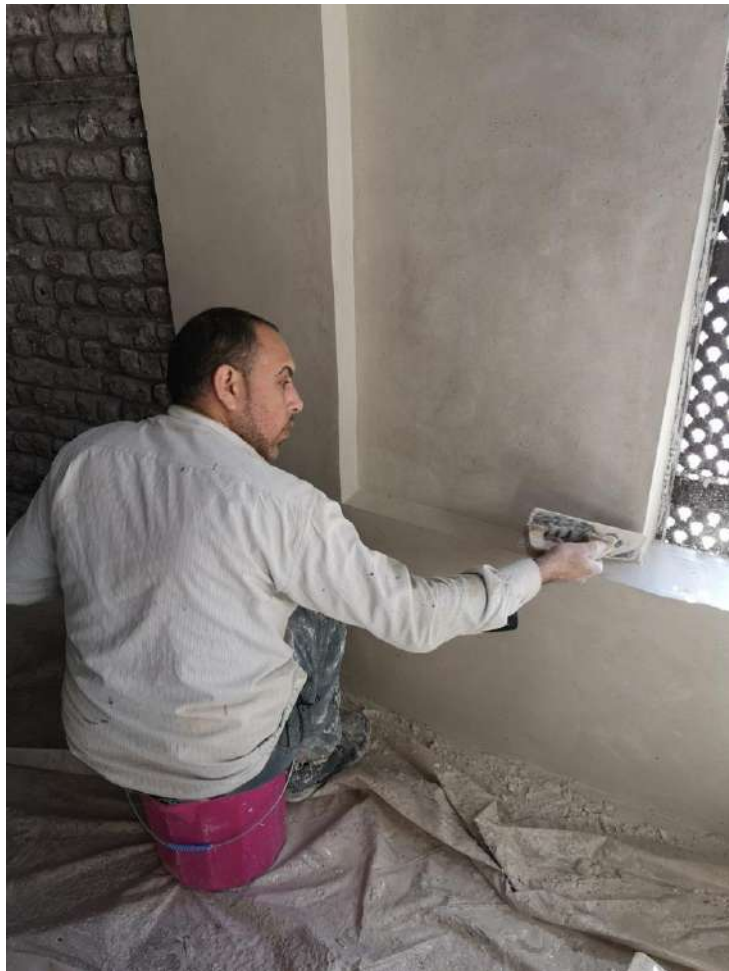
Fig. 28 Fasi di applicazione dell'intonaco di finitura al secondo piano
