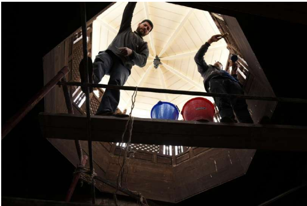
Fig. 22 Copertura del shoukhshikha
