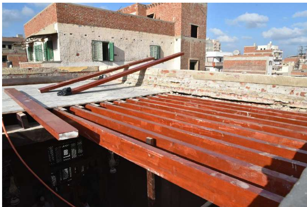
Fig. 20 Installazione delle nuovi travi di legno
