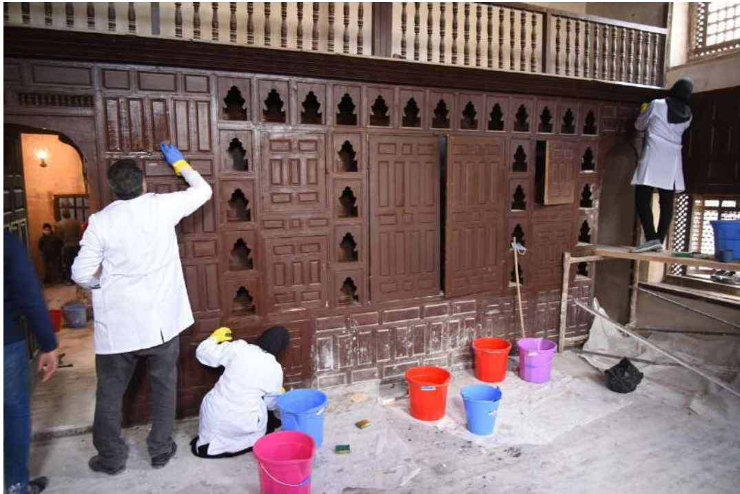
Fig. 29 Pulitura della struttura in legno
