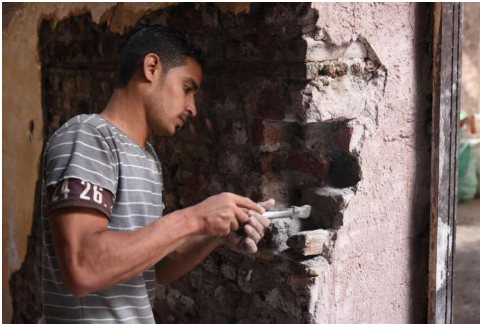
Fig. 26 Stesura dell'intonaco grezzo di fondo
