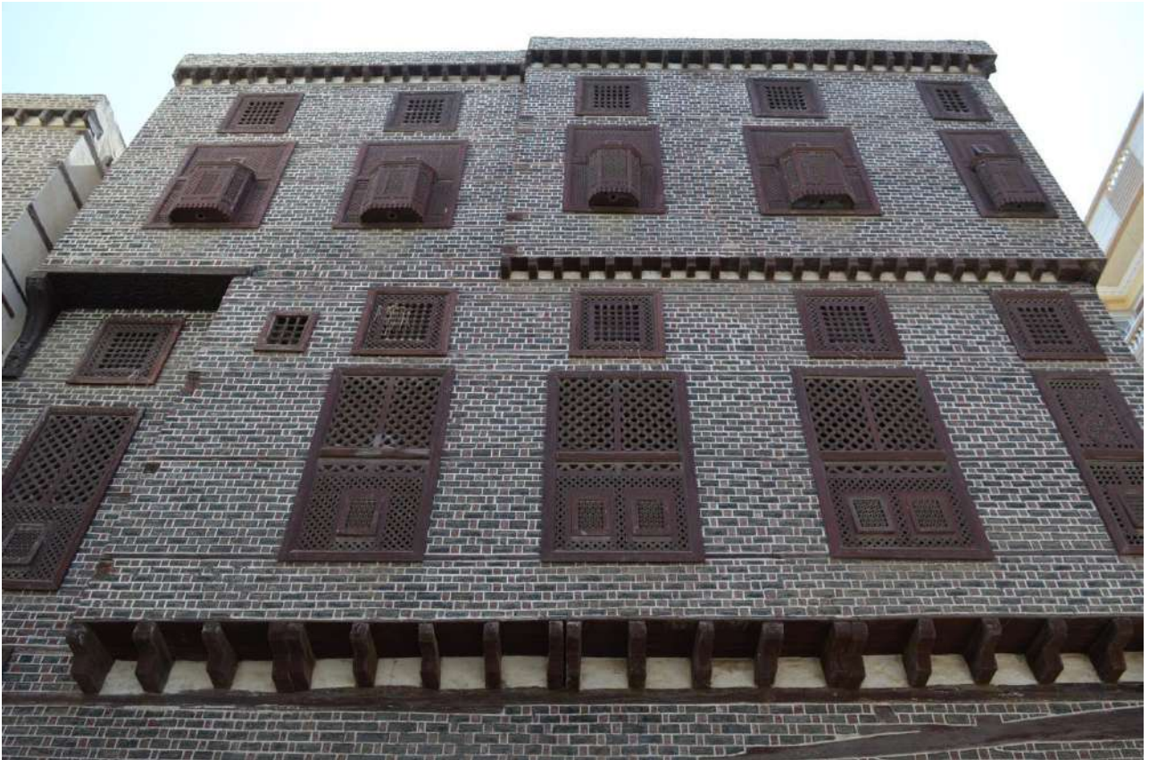
Fig. 4 Casa Amasili, muro esterno
