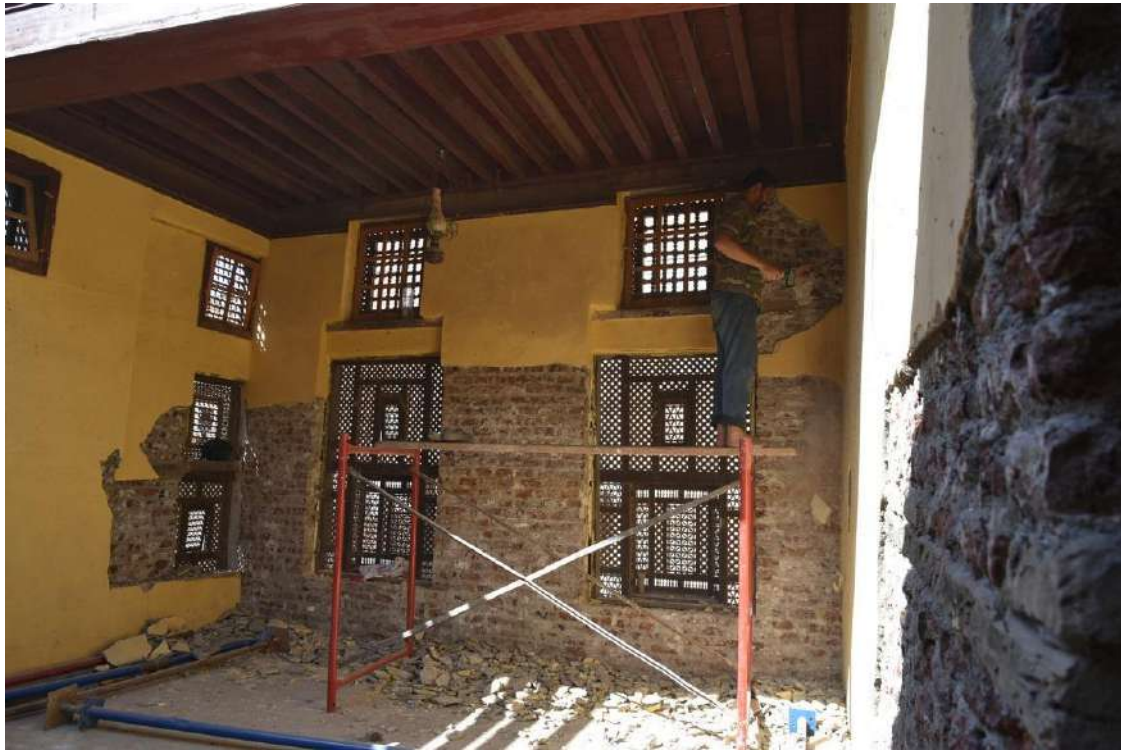
Fig. 23 Rimozione dello strato di cemento e degli interventi di restauro recenti
