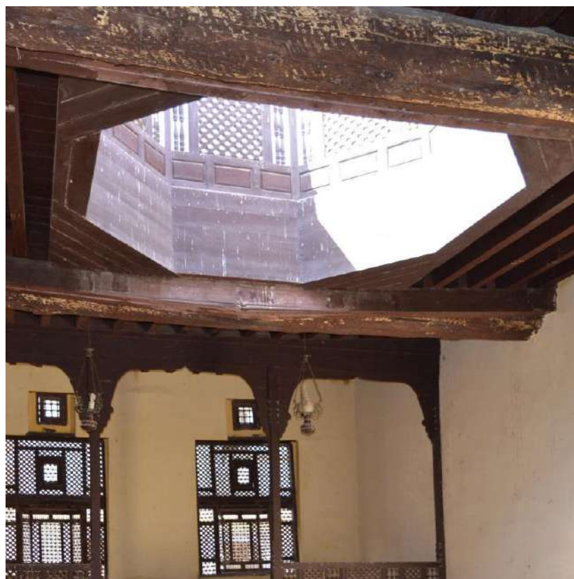
Fig. 16 Shukhshikha come si presentava all'inizio dei lavori
