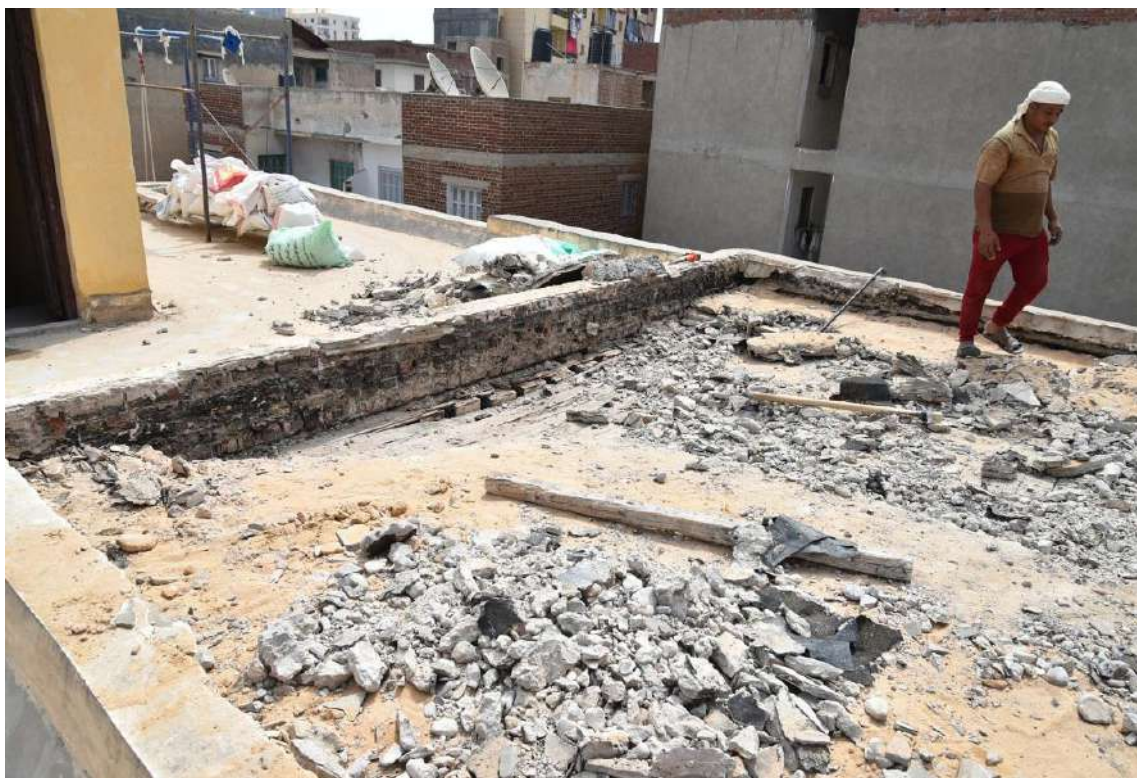
Fig. 18 Rimozione della pavimentazione della copertura, da cui emerge l'inclinazione del tetto
