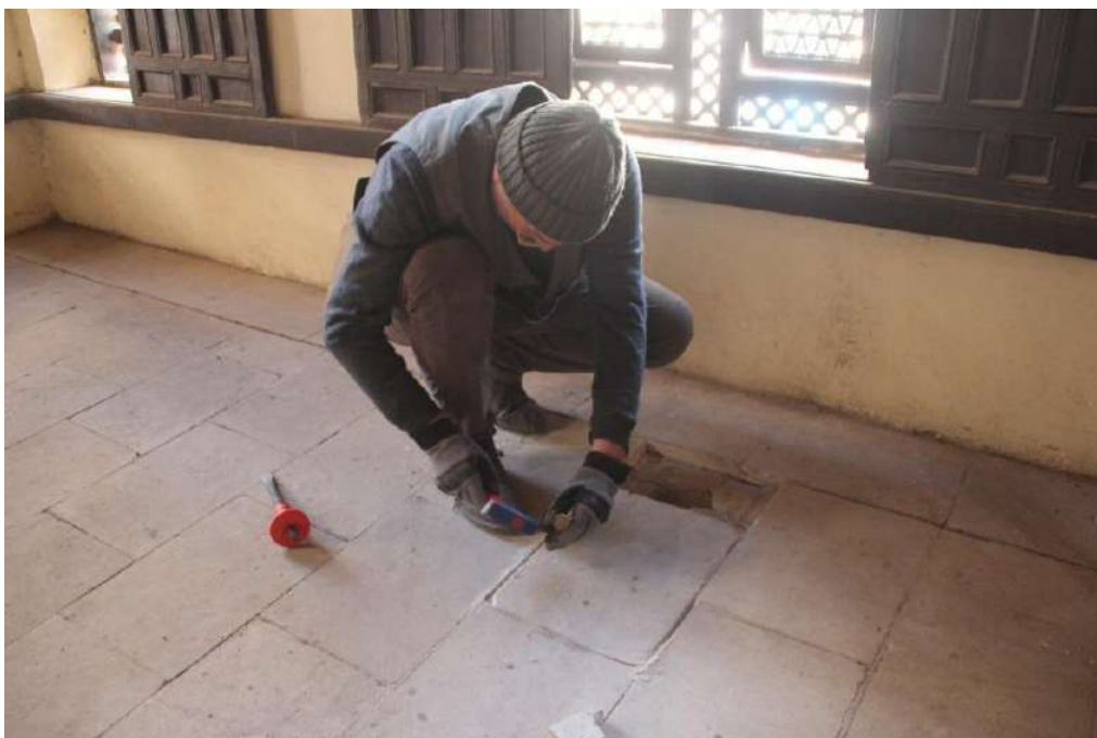
Fig. 12 Sondaggio nel pavimento del primo piano
