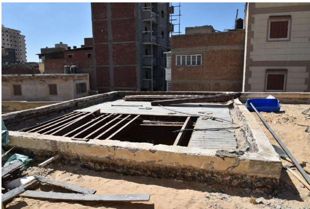
Fig. 19 Rimozione delle travi di legno consumate
