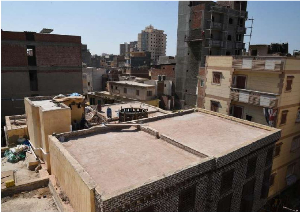
Fig. 21 Primo livello di massetto a copertura della travatura
