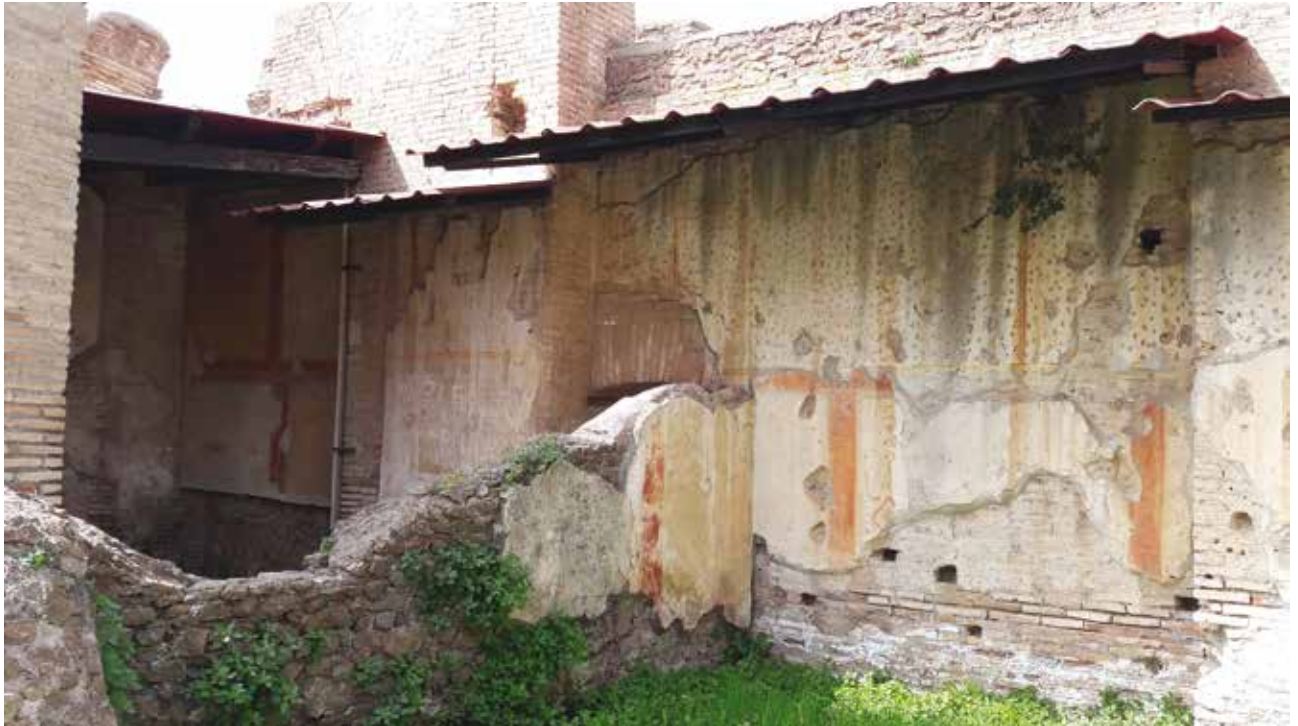
◆ Fig. 5. Caseggiato degli Aurighi. Ambienti 8 e 9, pareti ovest (foto S. Falzone).
