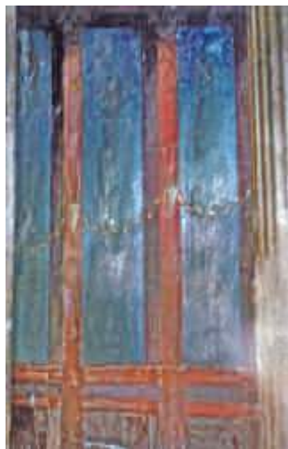
a lato Fig. 8 - Oplontis , Villa, ambiente 15, particolare (foto Autore).
