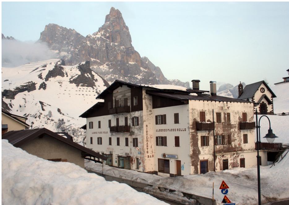
Fig. 2 - L’Albergo Passo Rolle prima della demolizione
