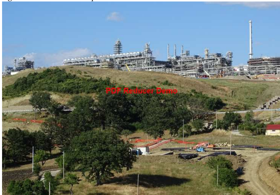
Fig. 5 – Il Centro Olio Tempa Rossa in costruzione
