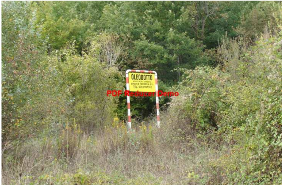
Fig. 4 - Pannello indicante la presenza dell'oleodotto interrato
