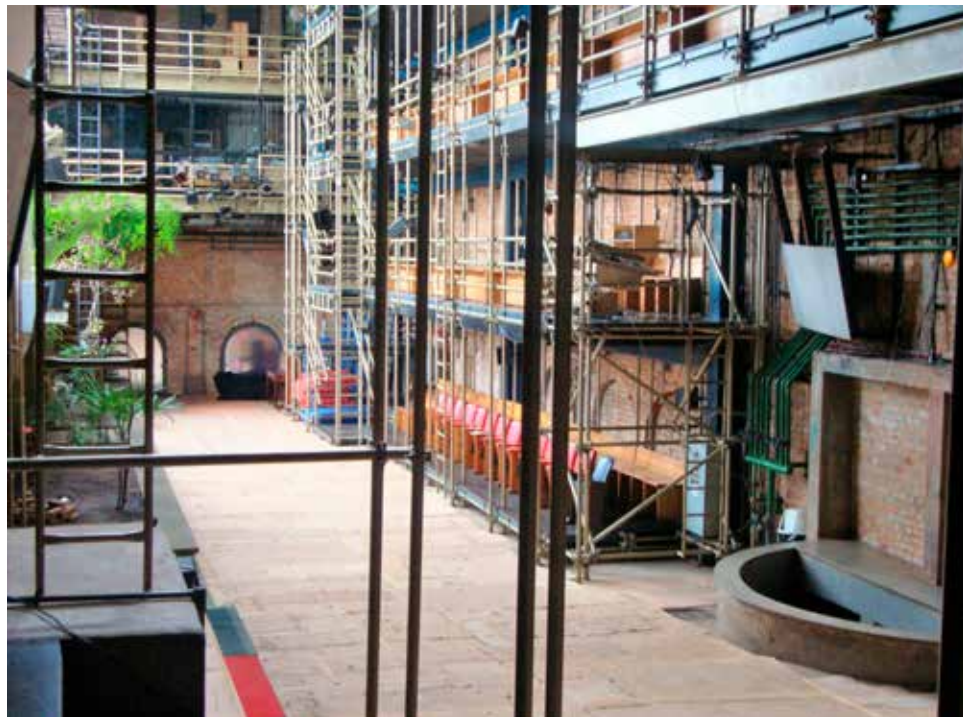
Teatro Oficina – i diversi materiali e strutture dell'interno. Foto Cassia Monteiro (Archivio del Laboratório de Estudos do Espaço Teatral e Memória Urbana).
