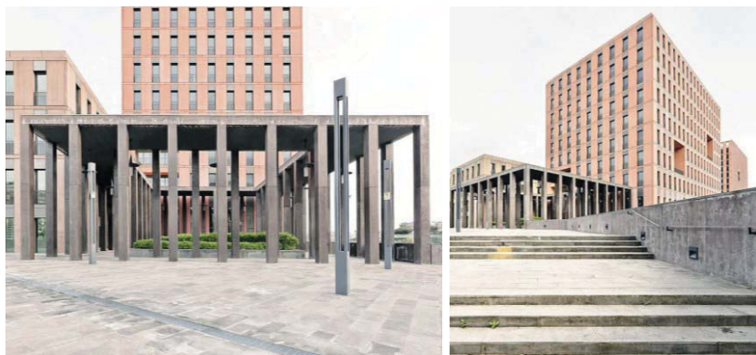
David Chipperfield, palazzo di Giustizia a Salerno, Italia 2007.
