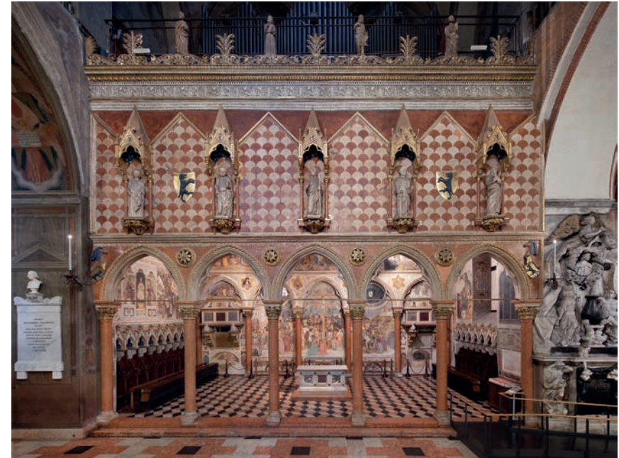
Fig. 10 - Padova, Basilica di Sant'Antonio, cappella di San Giacomo, prospetto frontale.
