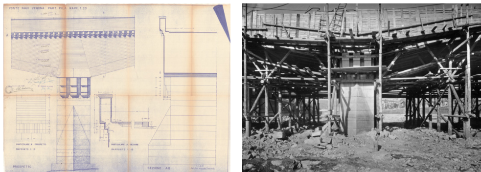
Fig. 5 – Ricostruzione di ponte delle Navi, 1947-49: dettaglio architettonico della pila (BCVr) e vista del cantiere durante i lavori (ASVr).
