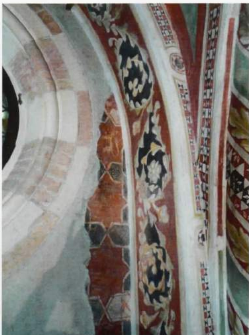
fig. 10.14 Cappella degli Scrovegni, abside, parete di fondo, lato destro, monofora e spessore della nicchia
