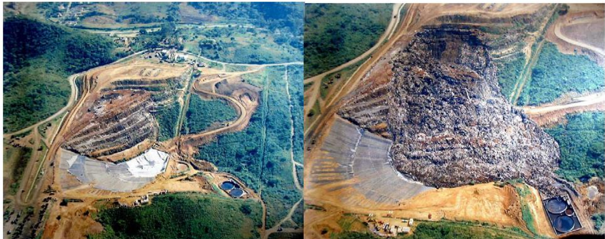
Fig. VIII-1. Esempio di rottura di un cumulo di rifiuti (Durban, Sudafrica) (Brink et al., 1999).
