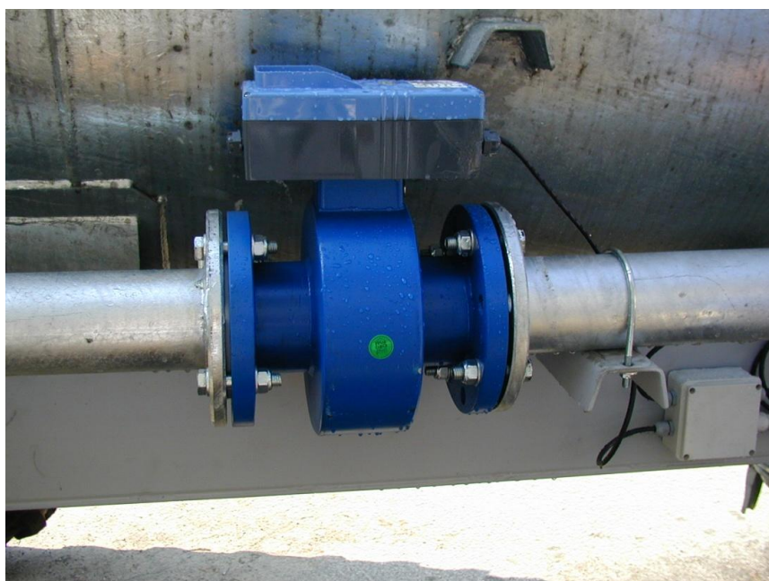
Figura 4.15- Flussometro utilizzato per la misurazione della portata in mandata.
