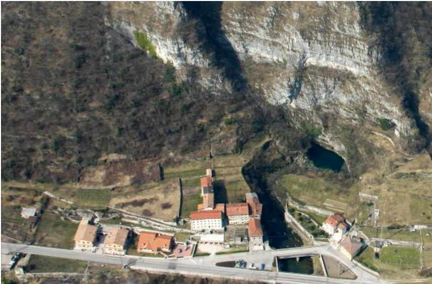
Figg.30 e 31 - Fotografia aerea del sito pilota di Ponte Subiolo (Tres e Zatta, 2006) e elaborazione GIS del Catasto del Comune di Valstagna della stessa area con evidenziati i terreni interessati dal progetto (Elaborazione dell'autore).
