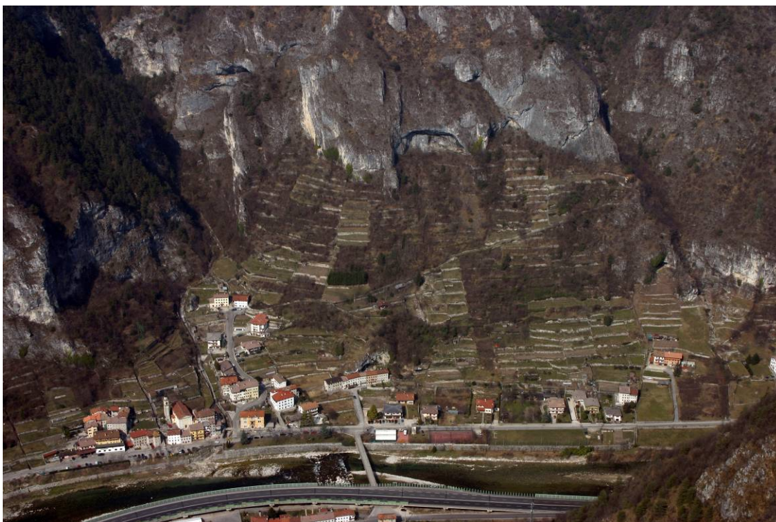
Fig.10 - I terrazzamenti in località Costa a Valstagna (Guido Medici 2006).
