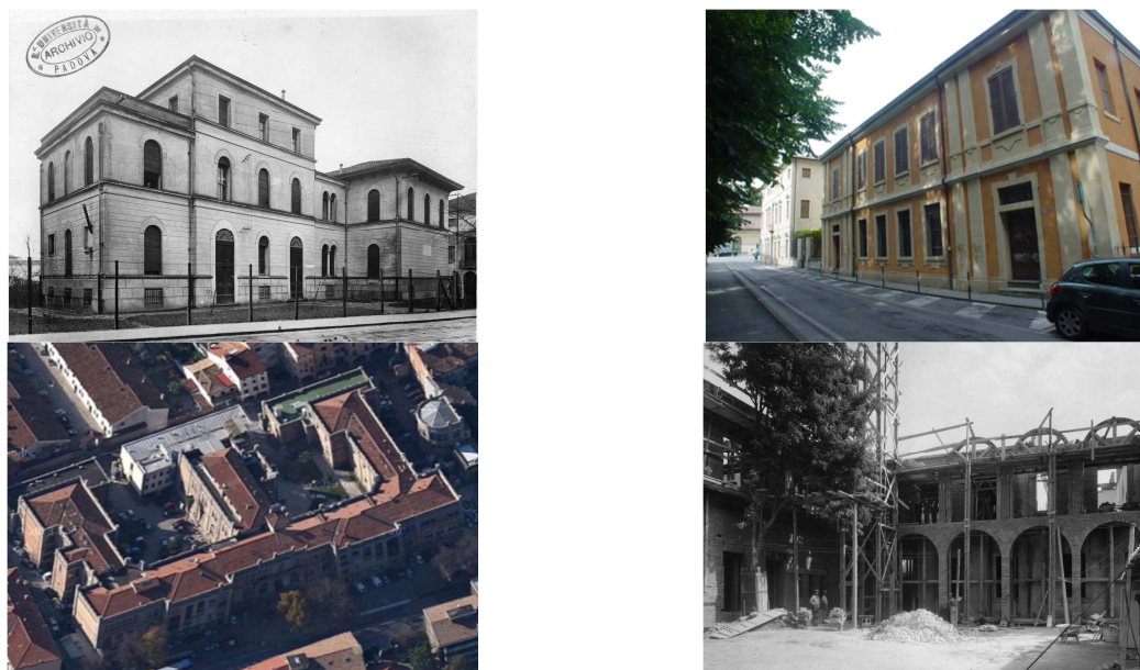
Figura 2.11: Esempio di edifici in muratura presenti nel patrimonio edilizio dell'Ateneo di Padova (Archivio Generale di Ateneo)
