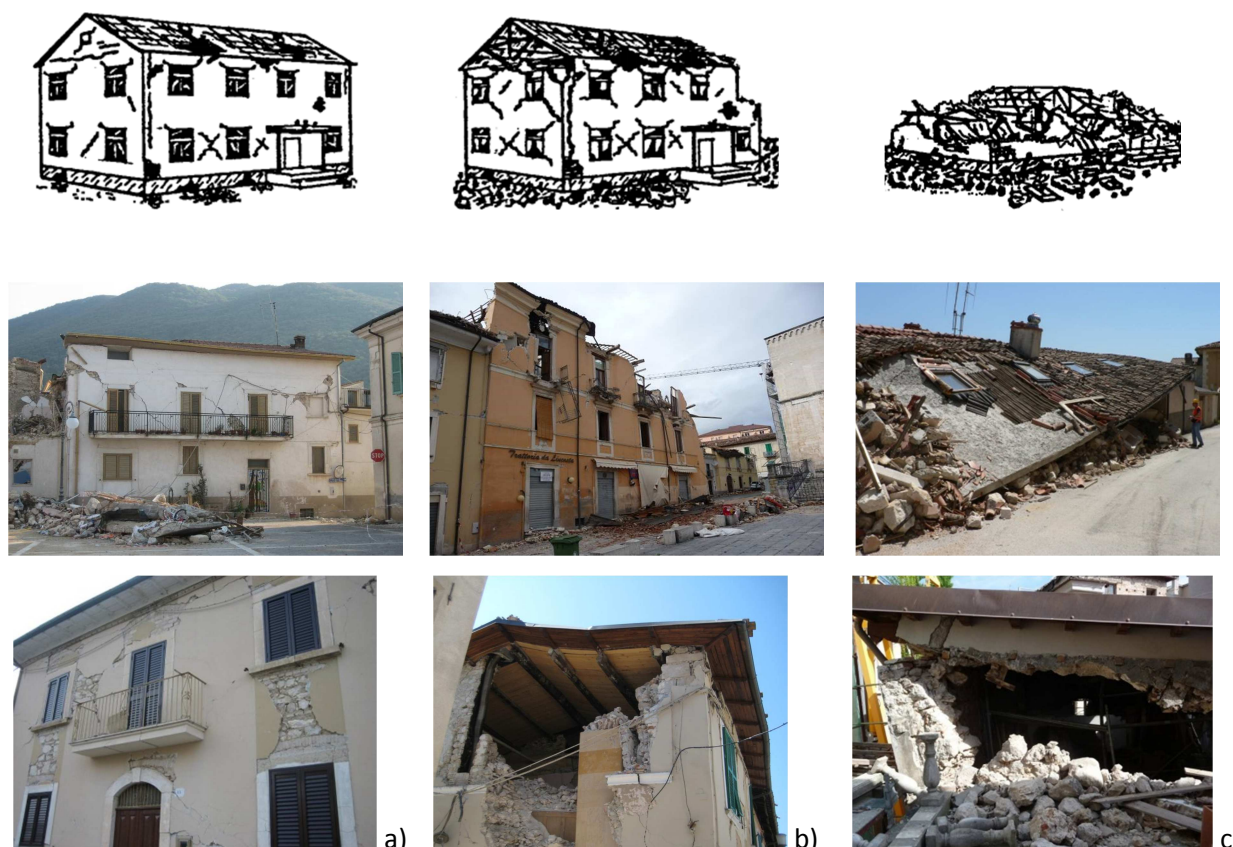
Figura 6.14: Grado di danno per edifici in muratura: a) grave, b) molto grave e c) distruzione
