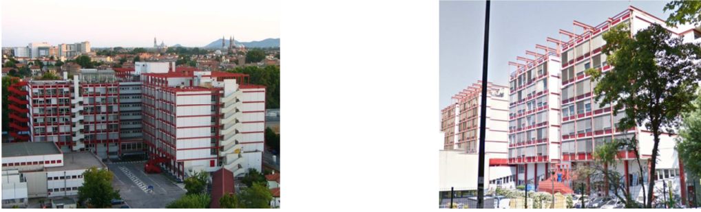
Figura 2.14: Esempio di edificio in acciaio presente nel patrimonio edilizio dell'Ateneo di Padova
