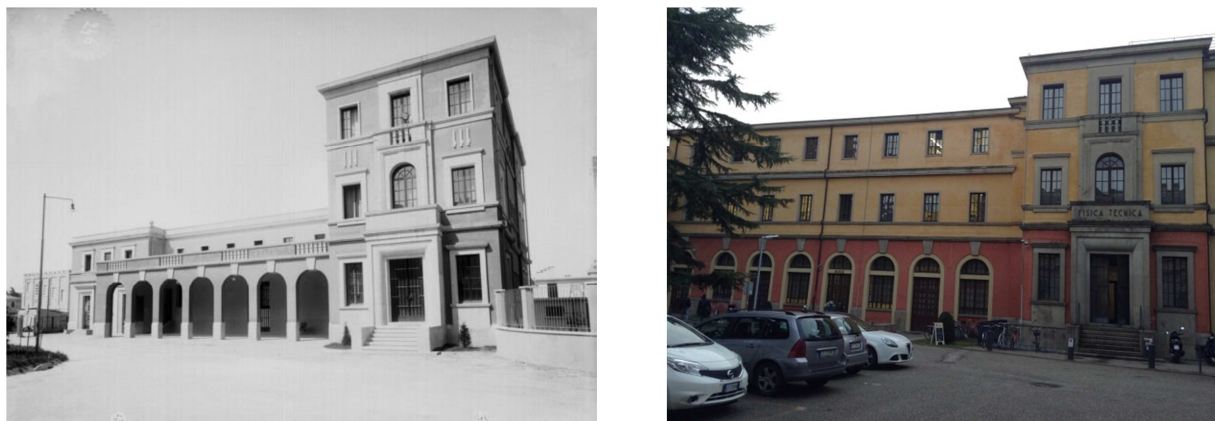
Figura 2.30: Analisi storico critica: esempio dell'edificio ex Fisica Tecnica dell'Università di Padova, confronto tra la configurazione del 1935 (Archivio Generale di Ateneo) ed attuale
