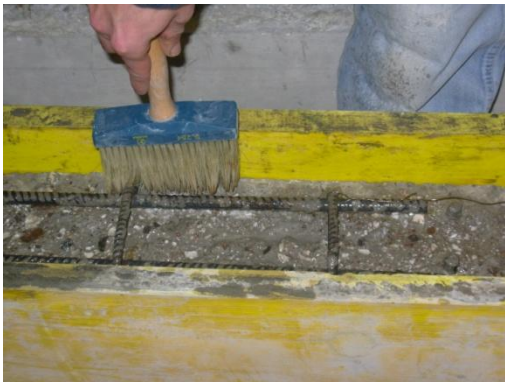
Figura 3.19: Bagnatura della superficie
