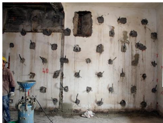
Figura 2.17: Tecniche di Applicazione: a) a cazzuola, b) per colaggio, c) a spruzzo e d) per iniezione
