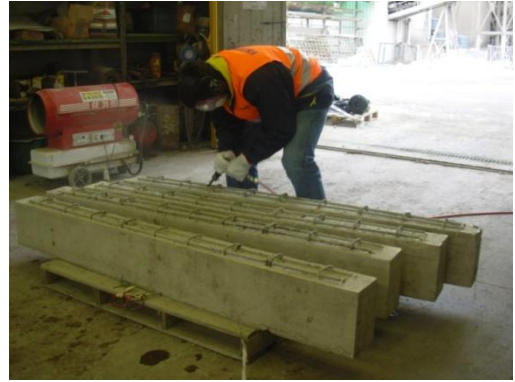
Figura 3.18: Irruvidimento della superficie
