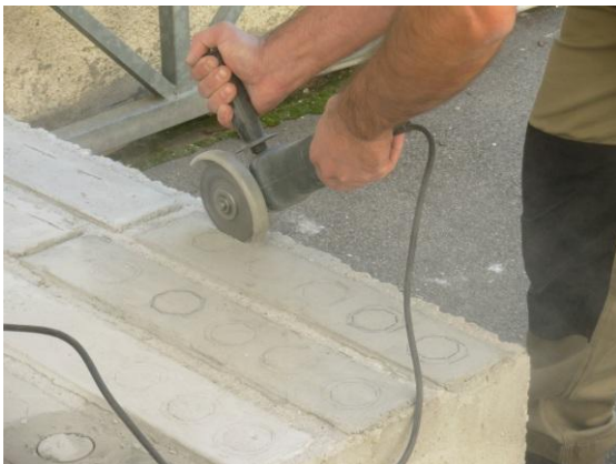
Figura 3.36: Incisione con fresa della superficie
