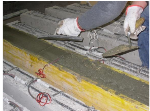
Figura 3.20: Applicazione strato di ripristino
