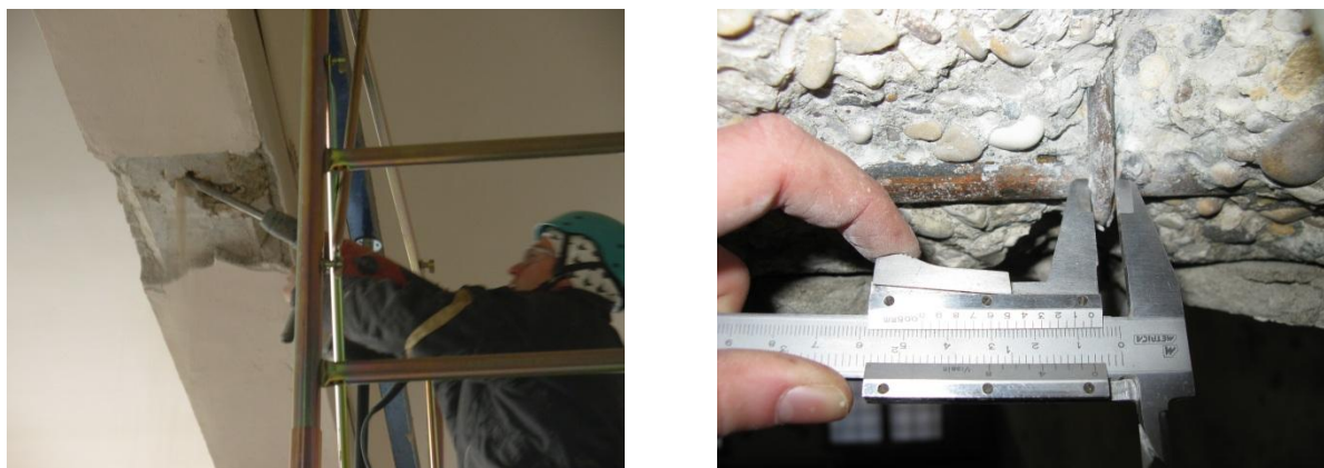
Figura 2.15: Prove Mediamente Distruttive - scarifiche
