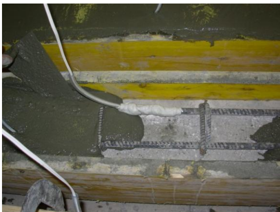
Figura 3.41: Applicazione della malta da ripristino
