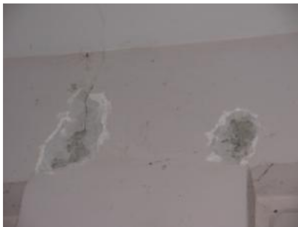
Figura 4.24: Particolare lesione nodo trave-colonna
