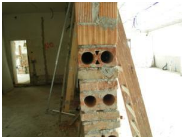
Figura 4.23: Particolare mattoni dei tamponamenti
