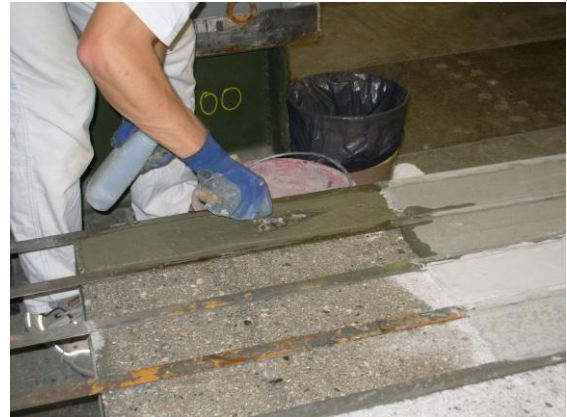
Figura 3.35: Applicazione delle strisce di SRG sulla piastra di calcestruzzo
