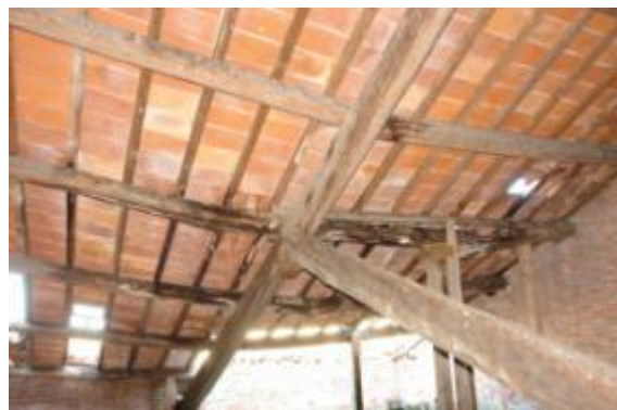
Figura 4.5: a) Infiltrazioni di acqua dal solaio e b) degrado delle travi lignee di copertura
