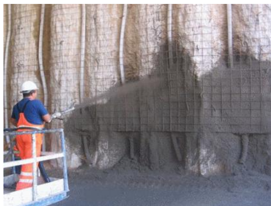
Figura 2.17: Tecniche di Applicazione: a) a cazzuola, b) per colaggio, c) a spruzzo e d) per iniezione
