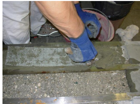
Figura 3.32: Impregnazione delle rete di acciaio
