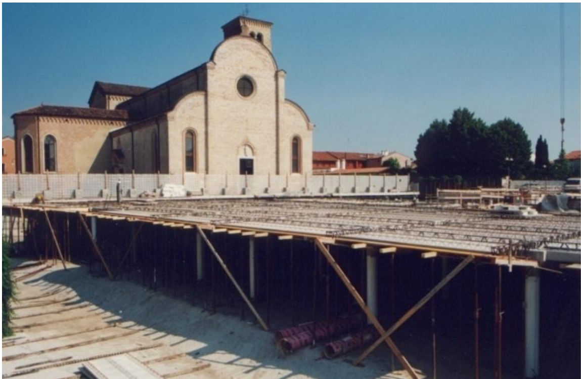
figura 3.18 – Veduta in fase di costruzione del piazzale
