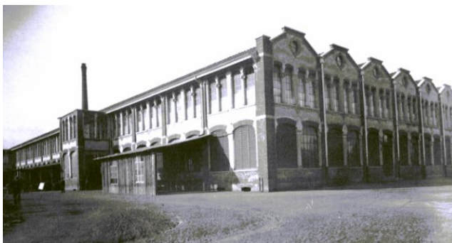
figura 1.2 – Cottonificio Remmert: vista esterna [1.1]
