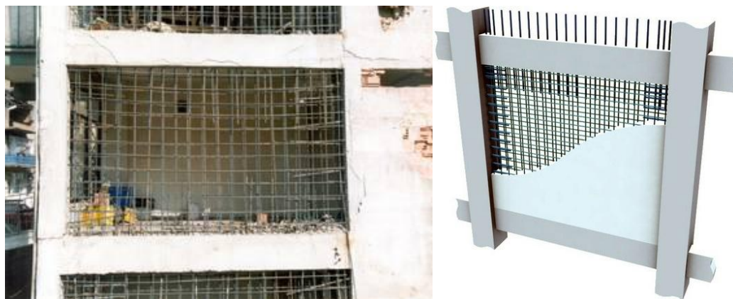
figura 1.85 – Interventi di miglioramento sismico mediante l'introduzione di tamponamenti gettati in opera [1.41]
