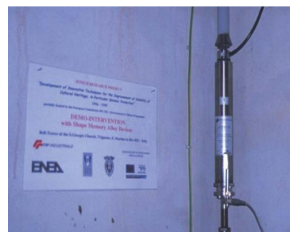
figura 2.50 – Dispositivo SMAD del campanile di San Giorgio a Trignano [2.35]
