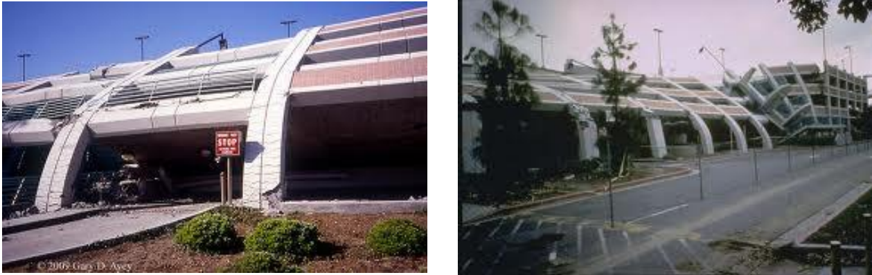
figura 1 – Immagini del collasso del parcheggio California State University a causa del terremoto di Northridge del 17/01/1994
