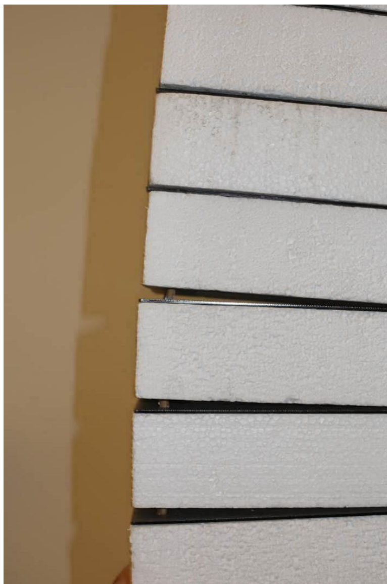
figura 2.84 - Fessurazione a trazione
