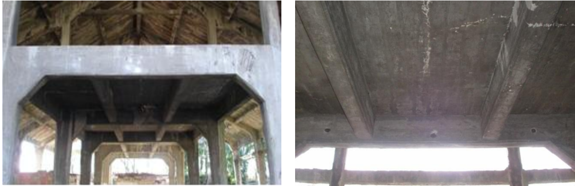
figura 1.131 – Vista delle travi del soppalco
