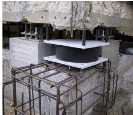
figura 1.89 – Inserimento isolatori sismici su un telaio esistente
