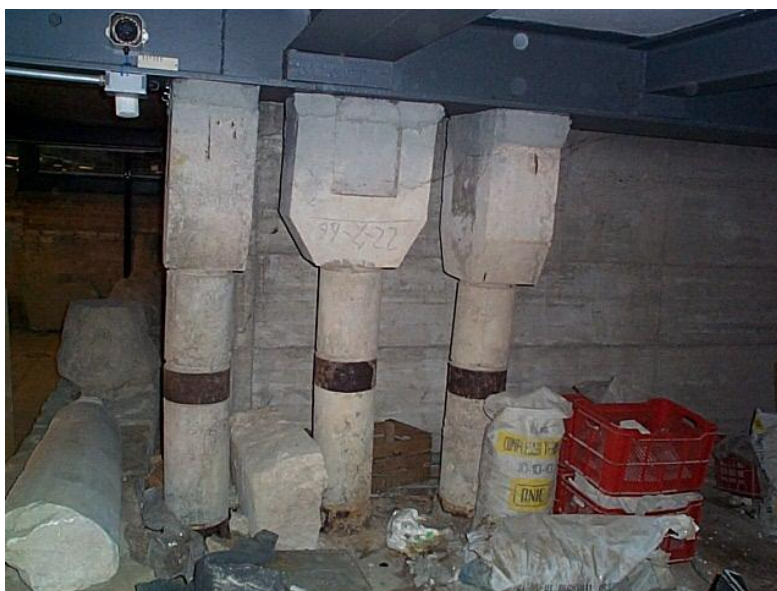
figura 3.32 – Immagine del “collegamento” trave-colonna
