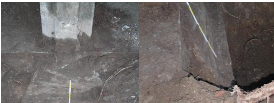
figura 1.138 – Analisi visiva delle fondazioni
