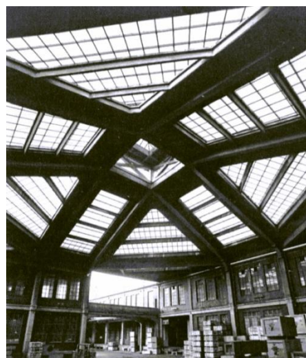
figura 1.29 – Magazzini generali piemontesi a Torino, 1913-14: vista interna [1.1]
