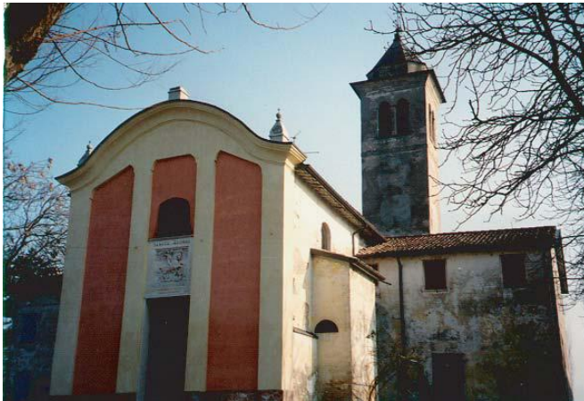
figura 2.47 – Chiesa e campanile di San Giorgio a Trignano [2.35]
