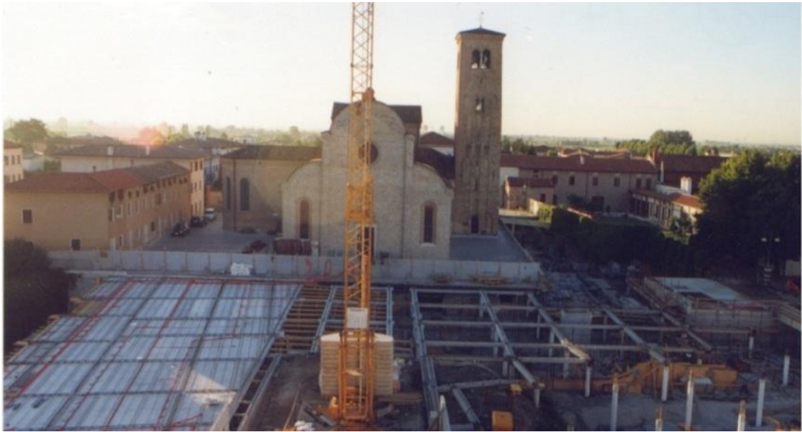
figura 3.17 – Veduta in fase di costruzione del piazzale
