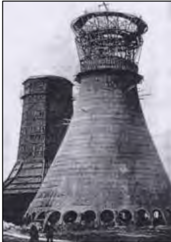
Figura 31a. 1918, la prima torre van Iterson – Kuypers a Limburg 29
