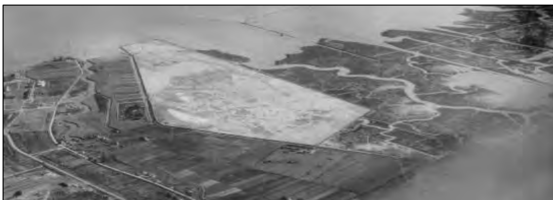
Figura 19. 1967, avvio delle bonifiche per la terza, non realizzata, zona industriale (Fonte: Archivio fotografico EZI)
