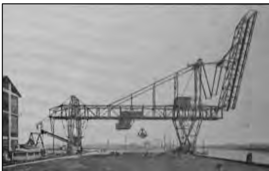
Figura 55a. 1930, sistemi per scarico carbone alla centrale termoelettrica (fonte: M. Mainardis, Centrale termoelettrica di Venezia-Marghera della Società Adriatica di Elettricità , Milano 1930)
