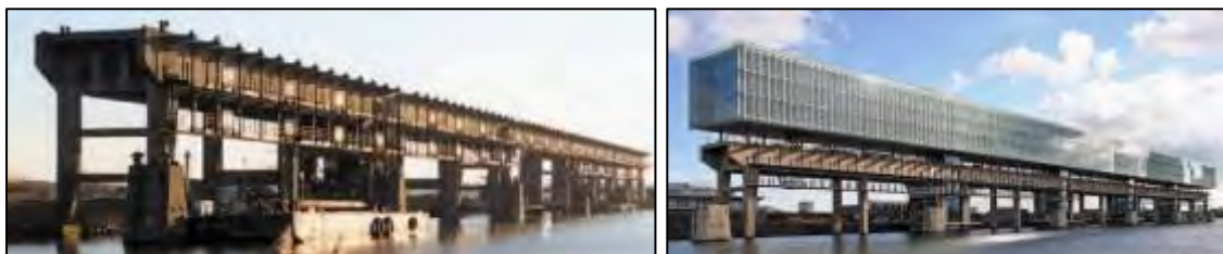
Figura 85. 2008, Amsterdam: gli uffici Kraanspoor costruiti sulla struttura di un carroponete in cemento armato (fonte: immagini pubblicate in "Progetti e concorsi", maggio 2010, p.6)
