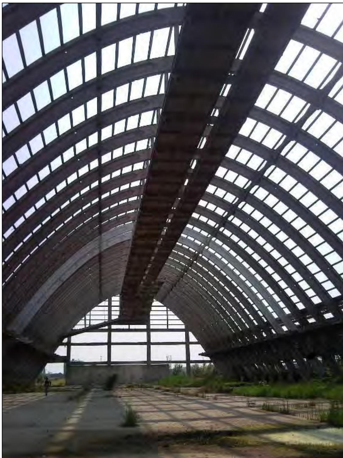
Figura 83. Il magazzino prodotti C2 nell'area ex fertilizzanti complessi, situazione attuale (fonte: foto F. Porchia 2010)
