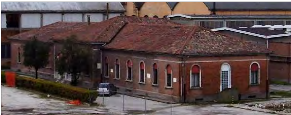
Figura 94. La palazzina degli uffici, unico elemento ritenuto dalla VPRG testimonianza della civiltà industriale in tutta l'area Complessi (Fonte: foto F. Porchia 2010)
