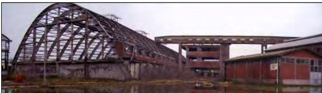
Figura 88b. 2008, al capannone è stata rimossa la copertura, ma il sito mostra ancora la sua coerenza, con il passaggio aereo tra magazzino e torre di insaccamento (fonte: foto F. Porchia)
