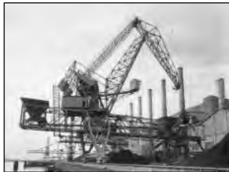
Figura 55b. Sistemi per scarico carbone alla centrale termoelettrica negli anni '60 (fonte: Archivio EZI)
