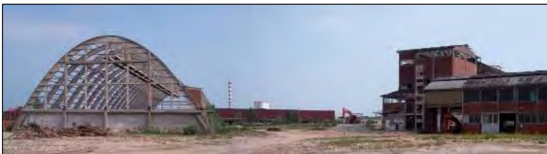
Figura 88c. 2010, vengono demolite tutte le strutture che inserivano il capannone nel ciclo produttivo oltre che una serie di accessori di servizio ancora presenti nel piazzale, quale la pesa per i camion e i binari ferroviari (fonte: foto F. Porchia)
