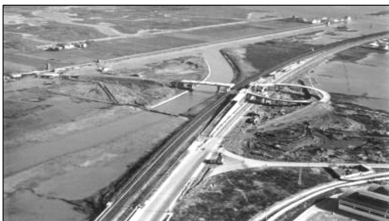
Figura 51. Anni '50, costruzione del cavalcavia di San Giuliano (fonte: archivio EZI)
