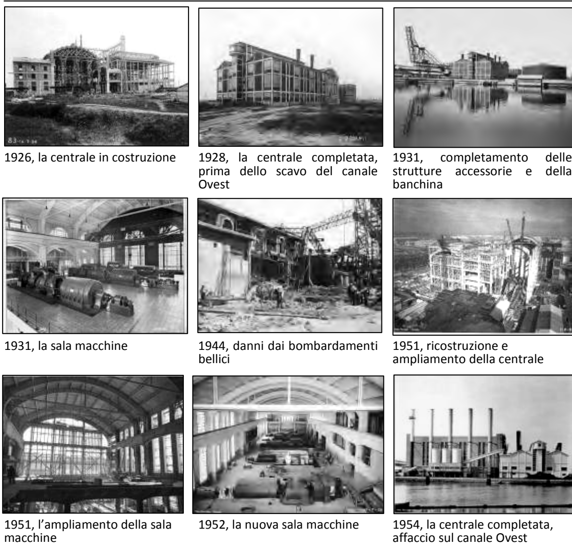
Figura 42. Costruzione e ampliamento della centrale termoelettrica G. Volpi (fonte: foto Ferruzzi, Archivio Storico Enel)
