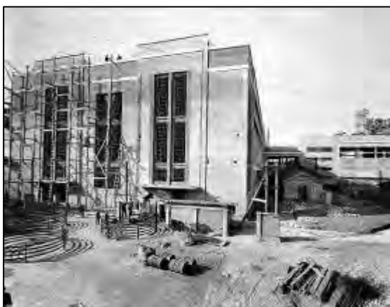
Figura 40a. 1936, stabilimento INA alluminio in costruzione (fonte: foto Giacomelli GP 000608)
