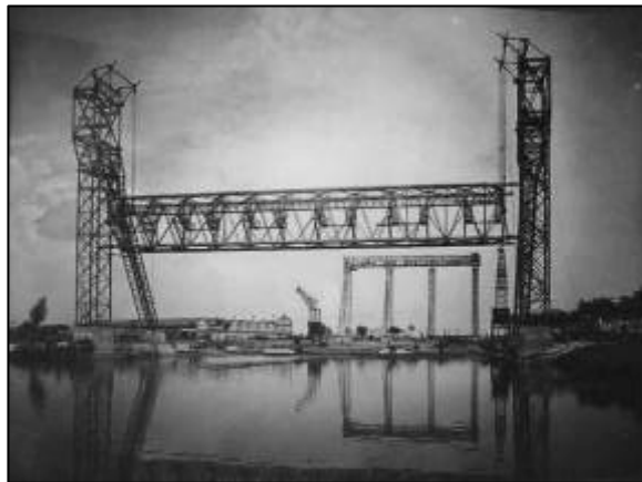
Figura 57a. 1938, montaggio del traliccio della teleferica (fonte: Archivio Breda)
