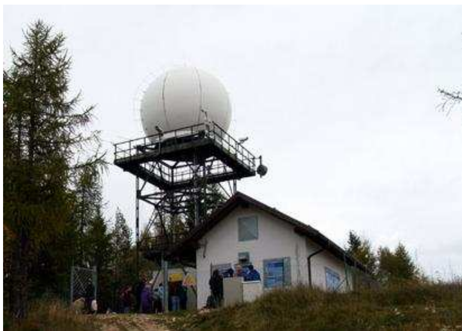
Figura 4.2: Il radar di Monte Macaion
