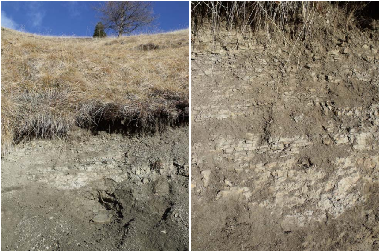
Figura 8. Frane presenti in sinistra idrografica rispetto al Rio Ponte vicino al sito Emme. Sulla destra uno zoom della superficie di distacco della frana.
