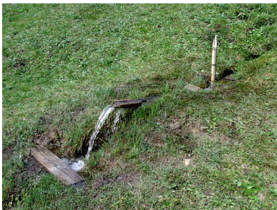
Figura 26. Sorgente con idrometri poco a valle dello stramazzo del Rio Ponte.
