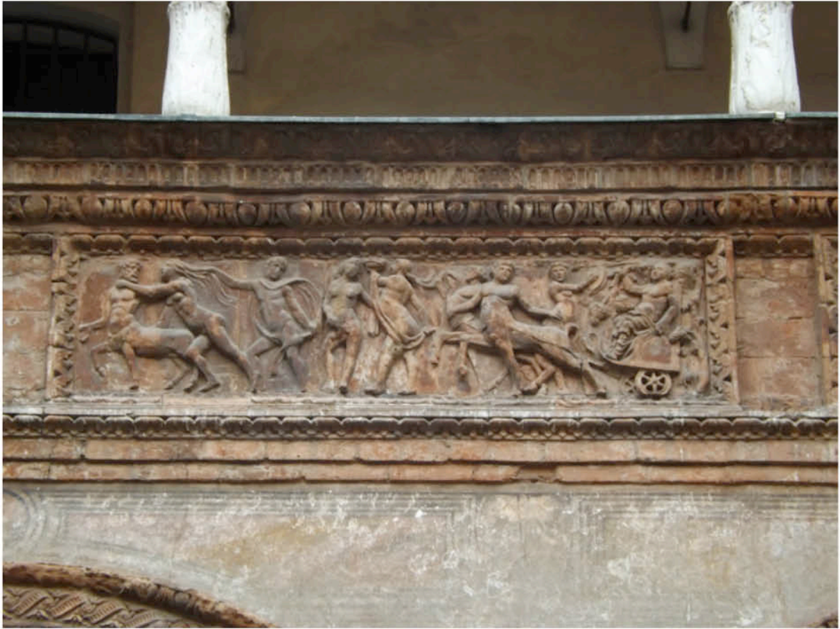
65. Cremona, Palazzo di Benedetto Fodri, particolare del fregio in terracotta del cortile.
