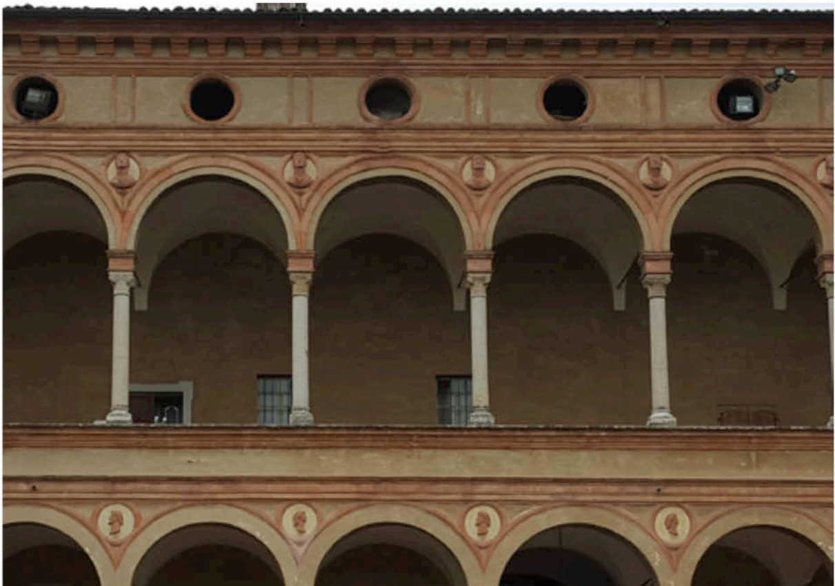
45. Palazzo Pallavicino, particolare del loggiato superiore del cortile.
