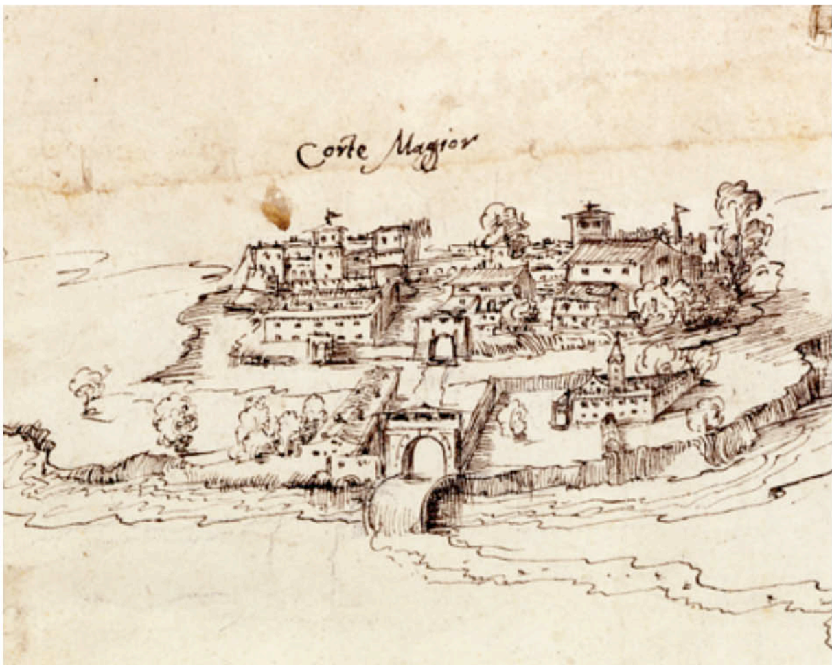
2. Mappa dello Stato Pallavicino, particolare con la veduta di Cortemaggiore della figura 6, ASPr, Mappe e Disegni 20-49.
