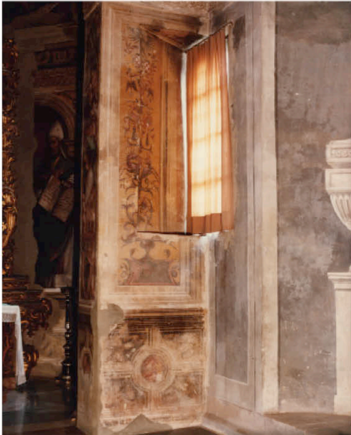
79. Cappella Pallavicino, chiesa della Santissima Annunziata, Cortemaggiore, particolare dell'angolo sud est.
