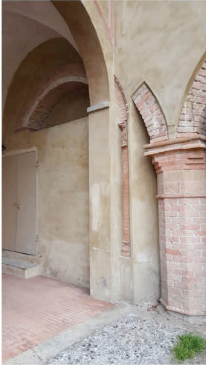
37. Palazzo Pallavicino, particolare del cortile con preesistenze
