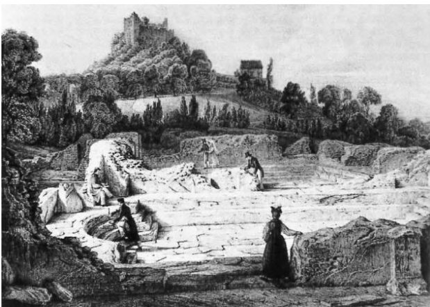
Figura 6: Litografia di G. Engelmann raffigurante le operazioni di scavo presso le rovine delle terme (1828). Fonte: Filgis 2002, p. 52 fig. 29.
