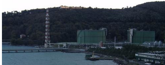
Figure 2.7 Panigaglia LNG onshore terminal
