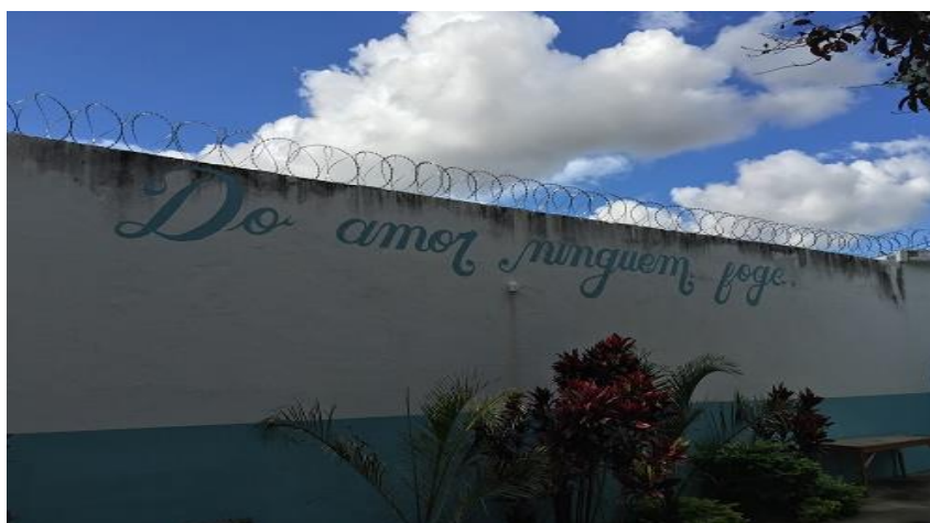
Figura 42 - Muro dell' APAC di Itaúna
