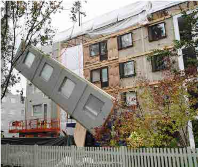
Figura 12. Il progetto Innova durante la fase di costruzione e montaggio dei pannelli di isolamento prefabbricati [Paroc Group, Kimmo Lylykangas]
