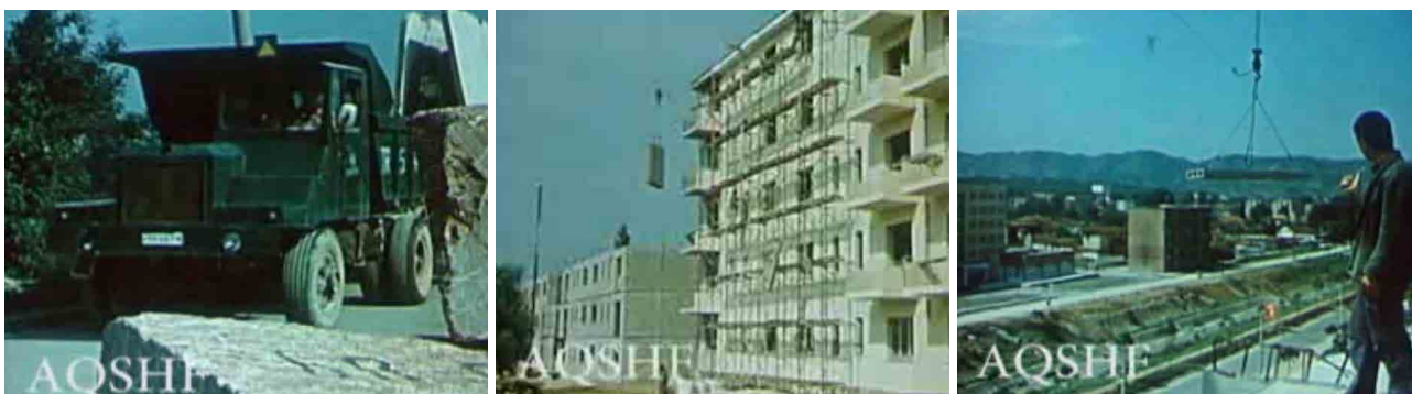
Figura 7. Immagini dal trasporto dei pannelli in cantiere e della fase di montaggio [AQSHF 1976]
