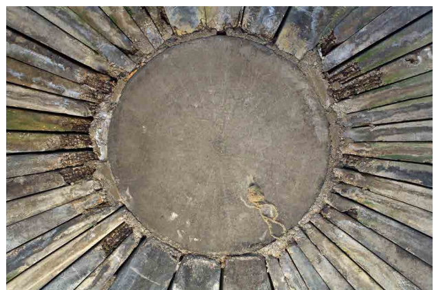
Figura 31. Immagine dell'interno della cupola del bunker PF [Robert Hackman 2019]
