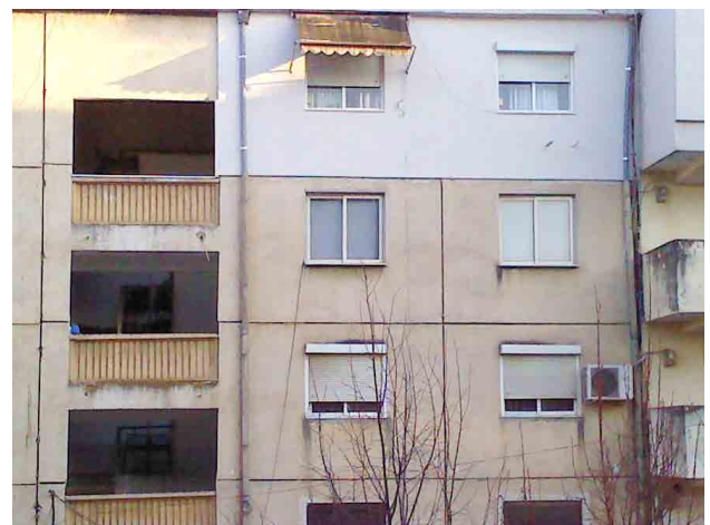
Figura 22. Umidità di risalita nella parte inferiore della muratura, scarico dell'acqua piovana sui giunti tra i pannelli causa della corrosione dei elementi di connessione.
