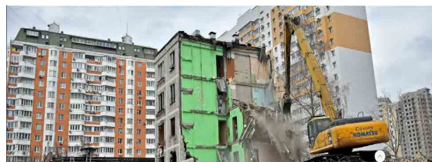
Figura 5. Operazione di demolizione delle “Khrushchyovka” a Mosca [Stroi 2018]
