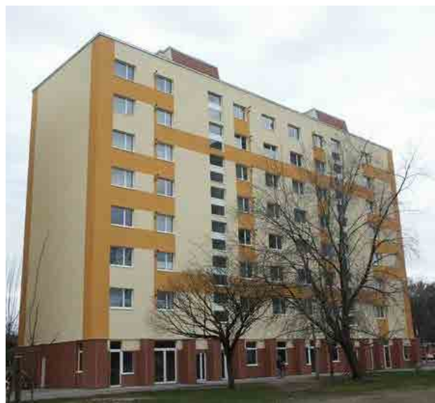
Figura 8. L'edificio del progetto pilota prima e dopo l'intervento
