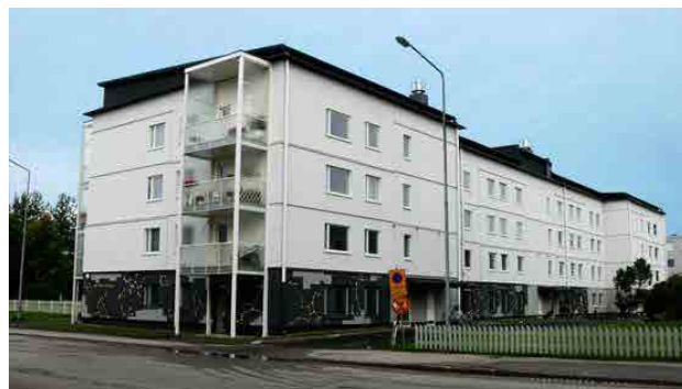
Figura 10. (a) Prima dell'intervento di riqualificazione, b) immagine dell'edificio dopo gli interventi di riqualificazione [Paroc Group]
