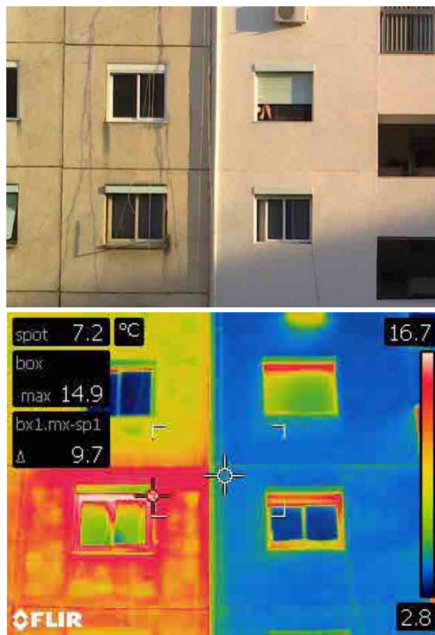
Figura 27. Termografia dell'appartamento rinnovato
