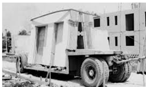
Figura 9. Veicoli con rimorchi adatti per il trasporto dei pannelli prefabbricati in cantiere [AQTN]
