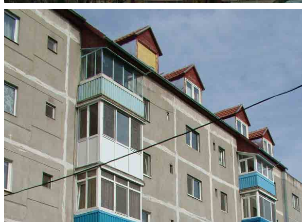
Figura 19. Edifici composti da pannelli prefabbricati in Romania [Botici 2013]
