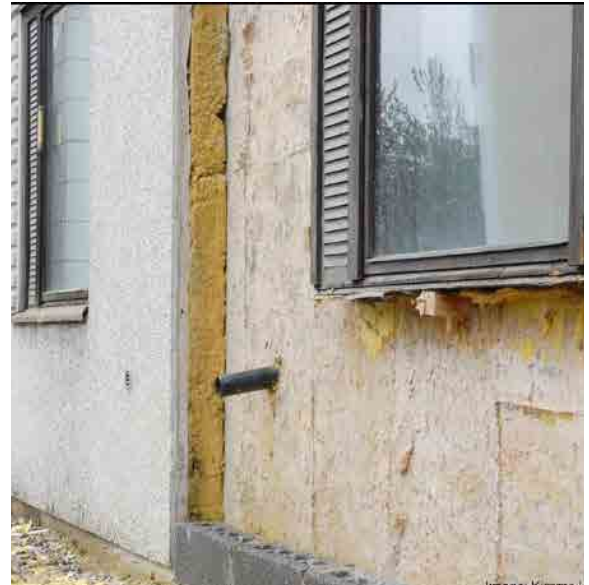
Figura 12. Il progetto Innova durante la fase di costruzione e montaggio dei pannelli di isolamento prefabbricati [Paroc Group, Kimmo Lylykangas]
