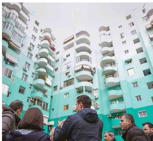
Figura 14. Edificio prima e dopo l’intervento di riqualificazione [Municipio di Tirana 2018]
