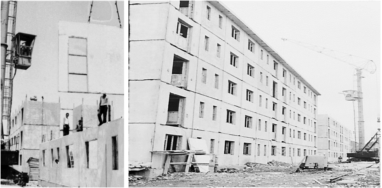
Figura 26. Montaggio dei pannelli tramite gru [AQTN]
