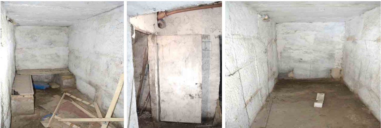
Figura 44. Spazi interni dei rifugi nei seminterrati degli edifici, quartiere Porcelani nella città di Tirana
