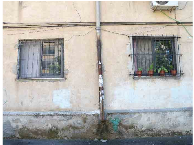
Figura 22. Umidità di risalita nella parte inferiore della muratura, scarico dell'acqua piovana sui giunti tra i pannelli causa della corrosione dei elementi di connessione.
