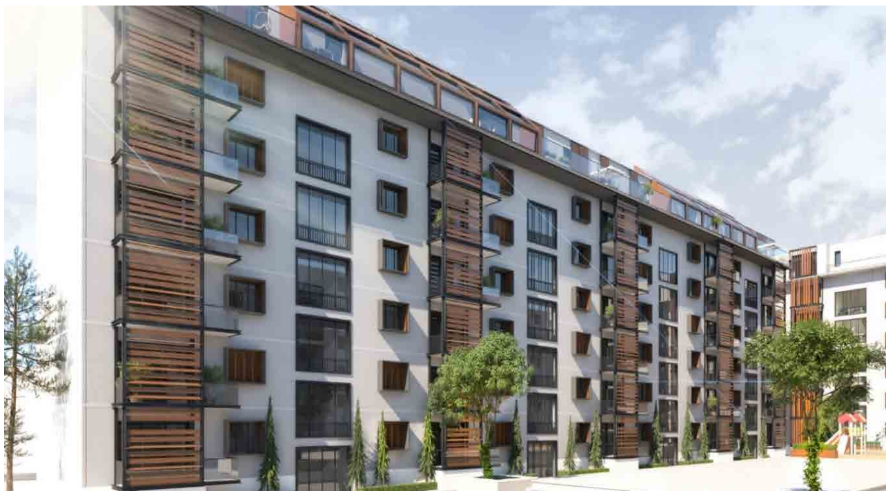
Figura 16. Vista della facciata sud-est V.1 (soluzione dei balconi con struttura in acciaio)
