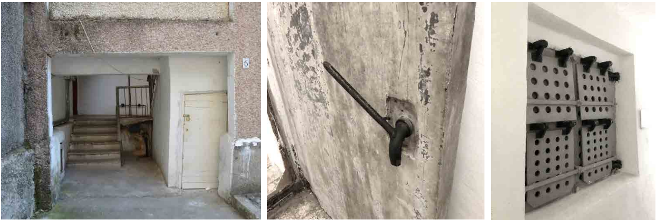
Figura 41 Immagini del rifugio anticrollo nel quartiere n.9 nella città di Tirana, (a) entrata dalla scala principale, (b) porta, (c) elemento di chiusura della finestra in caso di bombardamento
