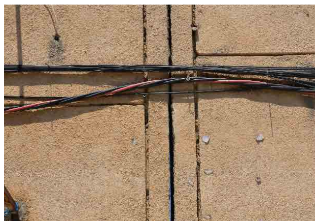
Figura 12. Unione di due moduli costruiti in periodi diversi (Modulo 40 e 41)
