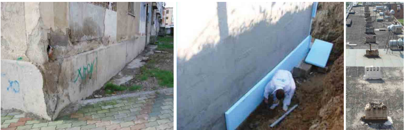
Figura 17. (a) Angolo della base dell'edificio, b) processo di isolamento, c) copertura esistente [Shehi 2010]
