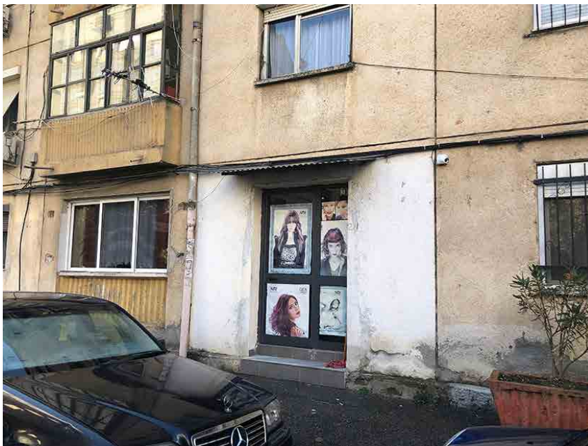
Figura 8. Apertura di (a) una porta e (b) finestre nel corpo dei pannelli esterni pieni
