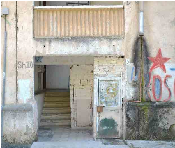
Figura 22. Umidità di risalita nella parte inferiore della muratura, scarico dell'acqua piovana sui giunti tra i pannelli causa della corrosione dei elementi di connessione.
